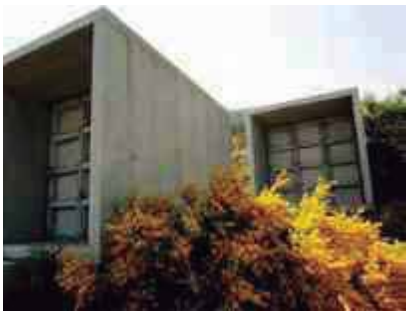
Fig. 44 Vista fachada de nichos
