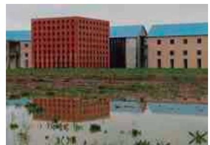
Fig. 40 Fachada de San Cataldo
