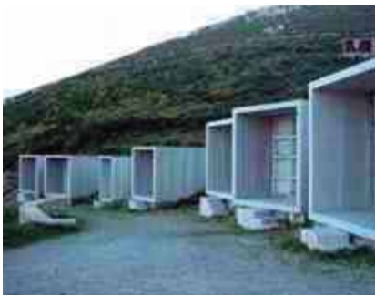
Fig.43 Vista fachada principal de nichos.
