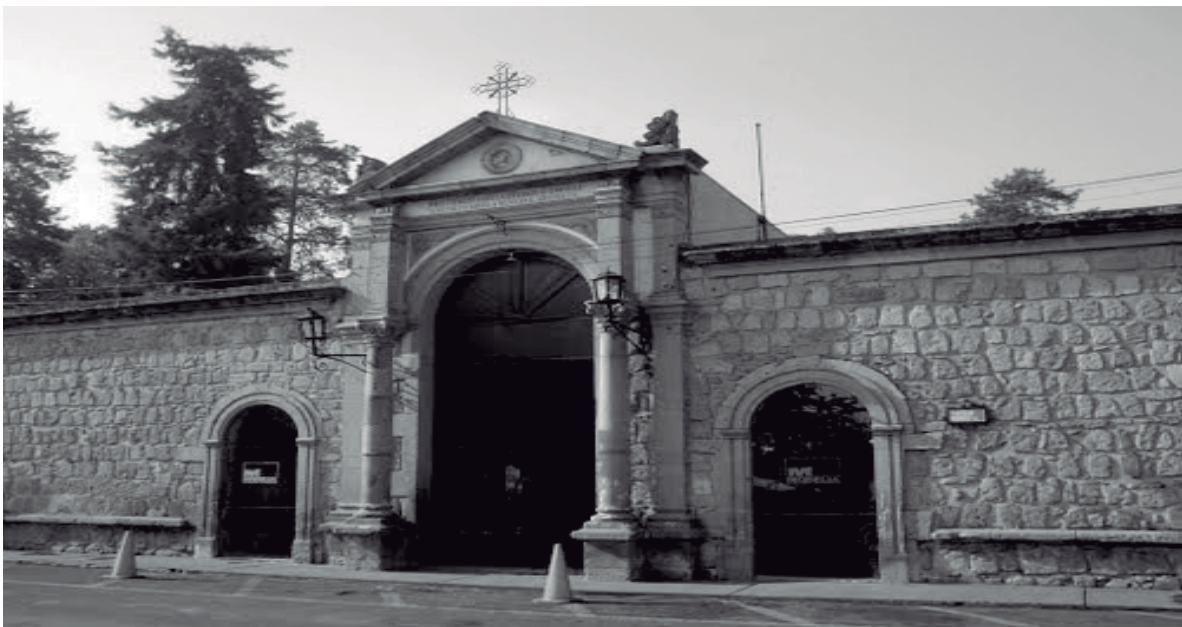
Fig.23 Fachada de acceso
