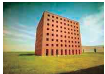
Fig.39 Fachada del cementerio
