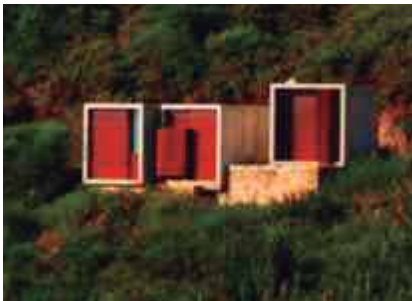
Fig.45 Vista fachada de nichos
