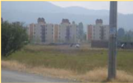
Foto 13. Vista a lo lejos del fracc. Tomada por Autor.
