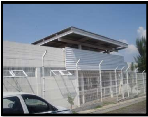
Foto 9. Salida de Emergencia.
