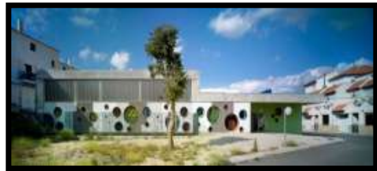
Foto23. Integración del Edificio
