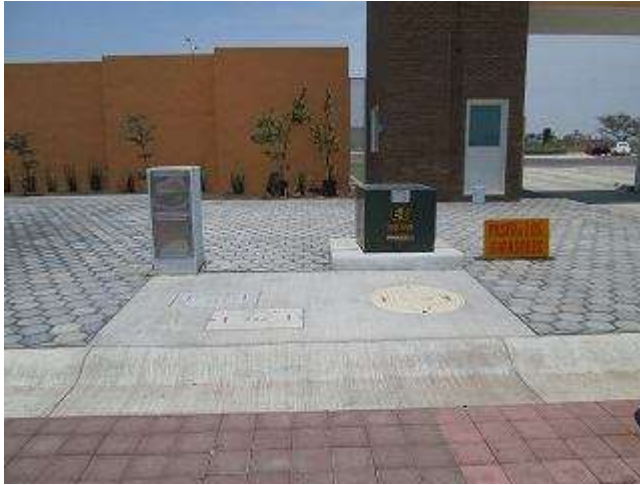
Imagen 59 y 60. Imagen izquierda media y alta tensión y a la derecha canalización alumbrado, telefonía y tele cable.
