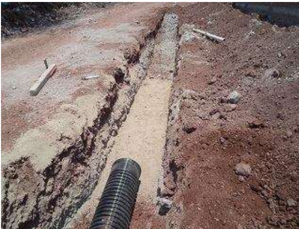
Imagen 55 y 56. Imagen izquierda tubo polietileno (ADS) de 15" y a la derecha pozo de visita y registro de toma domiciliaria.
