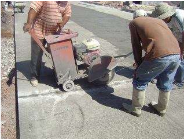
Imagen 63 y 64. Imagen izquierda corte de pavimento y a la derecha banqueta de 10 cm. de espesor.
