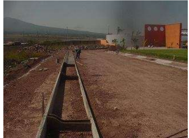
Imagen 53 y 54. Imagen izquierda base hidráulica y a la derecha guarnición de concreto.
