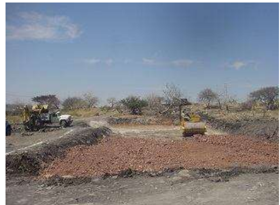
Imagen 51 y 52. Imagen izquierda excavaciones y a la derecha relleno de filtro tipo tezontle.
