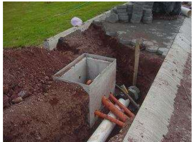
Imagen 57 y 58. Imagen izquierda caja de válvulas” y a la derecha tubería de PVC hidráulico RD 26 según diámetro.
