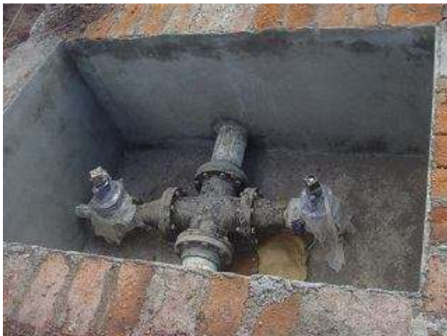
Imagen 57 y 58. Imagen izquierda caja de válvulas” y a la derecha tubería de PVC hidráulico RD 26 según diámetro.
