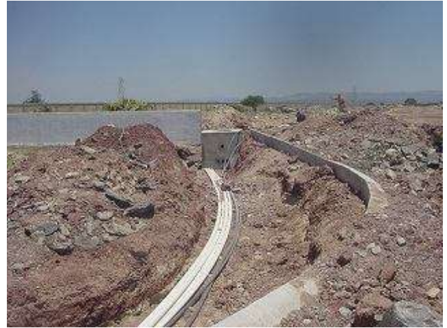
Imagen 59 y 60. Imagen izquierda media y alta tensión y a la derecha canalización alumbrado, telefonía y tele cable.
