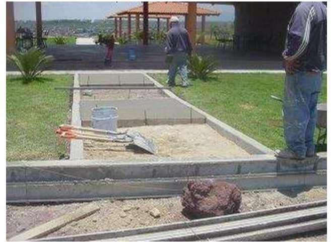
Imagen 63 y 64. Imagen izquierda corte de pavimento y a la derecha banqueta de 10 cm. de espesor.
