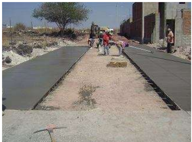
Imagen 61 y 62. Imagen izquierda adocreto en vialidades y a la derecha pavimento de 15 cm. de espesor.
