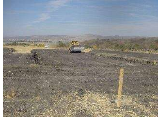
Imagen 49 y 50. Imagen izquierda ejes de referencia y a la derecha limpieza y nivelación
