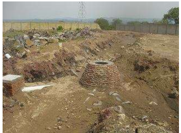
Imagen 55 y 56. Imagen izquierda tubo polietileno (ADS) de 15" y a la derecha pozo de visita y registro de toma domiciliaria.
