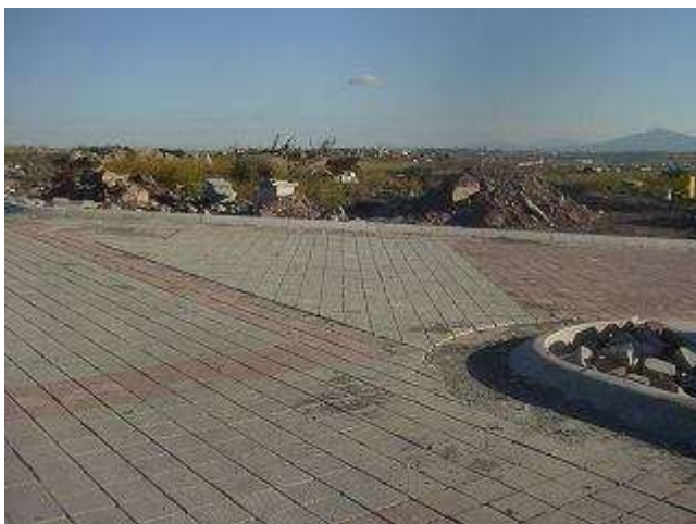
Imagen 61 y 62. Imagen izquierda adocreto en vialidades y a la derecha pavimento de 15 cm. de espesor.
