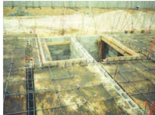
Imagen 88.- Construcción de una losa maciza.
