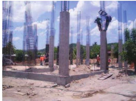
Imagen 87.- Construcción de columnas de concreto armado.
