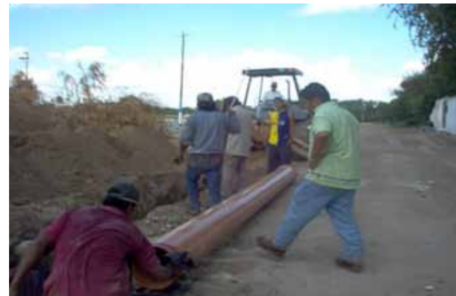
Imagen 4.9 Colocación de drenaje Fuente: (LALV Oct, 2011)
