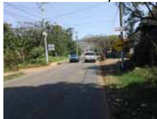
Imagen 6.14 Carretera federal Ziracuaretiro - Taretan. Fuente: (LALV Octubre, 2011)
