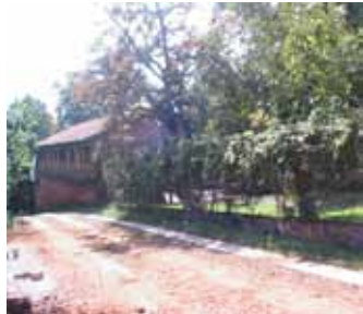
Imagen 6.7 Edificio del balneario Ziracuaretiro. Fuente: (LALV Octubre, 2011)
