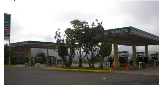
Imagen 4.8 Gasolinera el fresno de Ziracuaretiro. Fuente: (LALV Oct, 2011)
