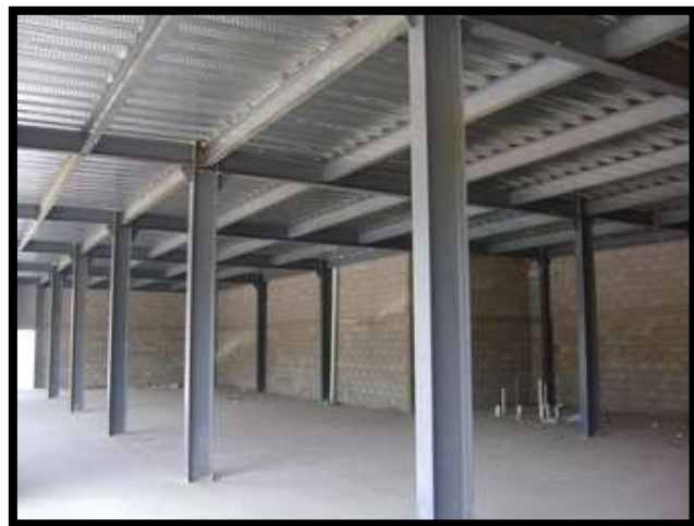
28. Estructura Metálica con sistema de entrepiso Losacero.
