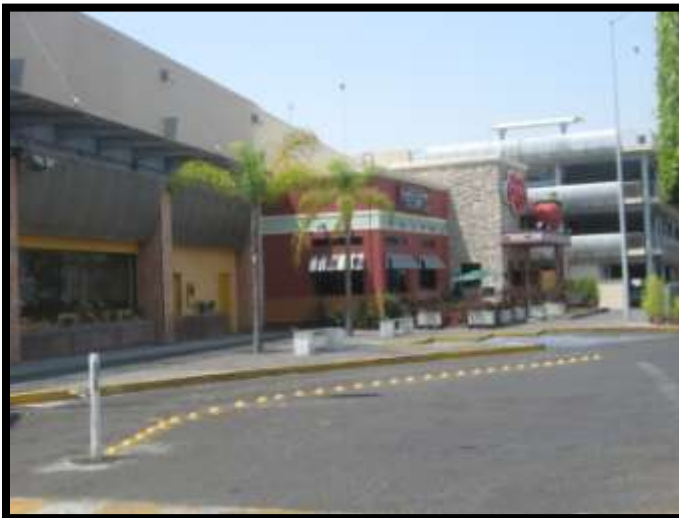
113. Vista Fachada de Restaurante y café exteriores
