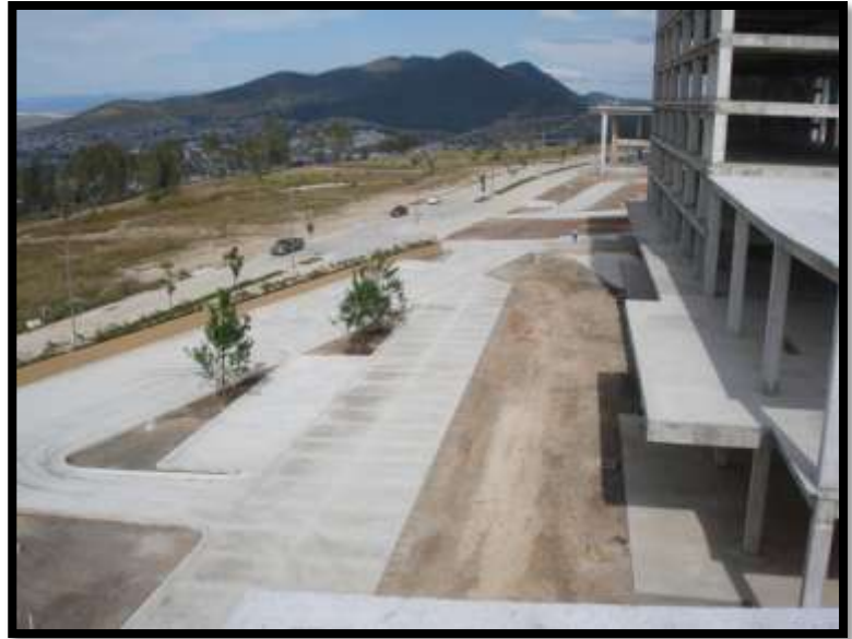
26. Estructura de Concreto.
