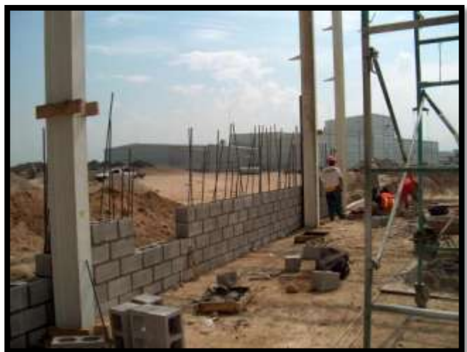
31. Proceso Constructivo de Muro Block Hueco
