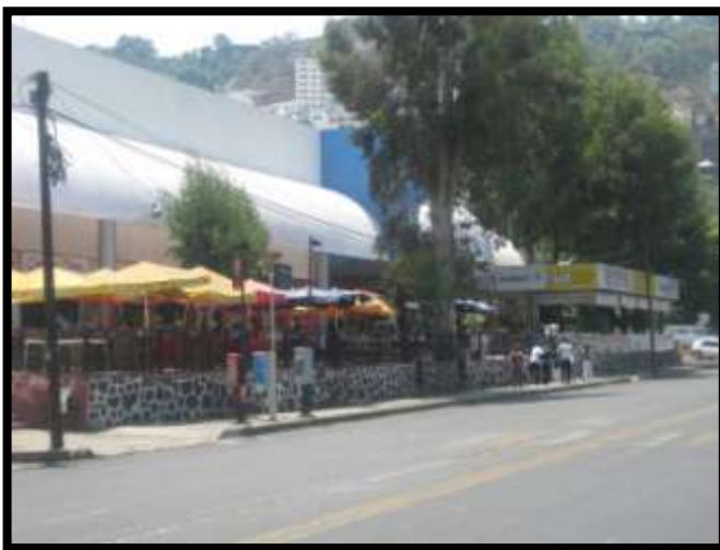
105. Vista de la Plaza Comercial por la Av. Ventura Puente.
