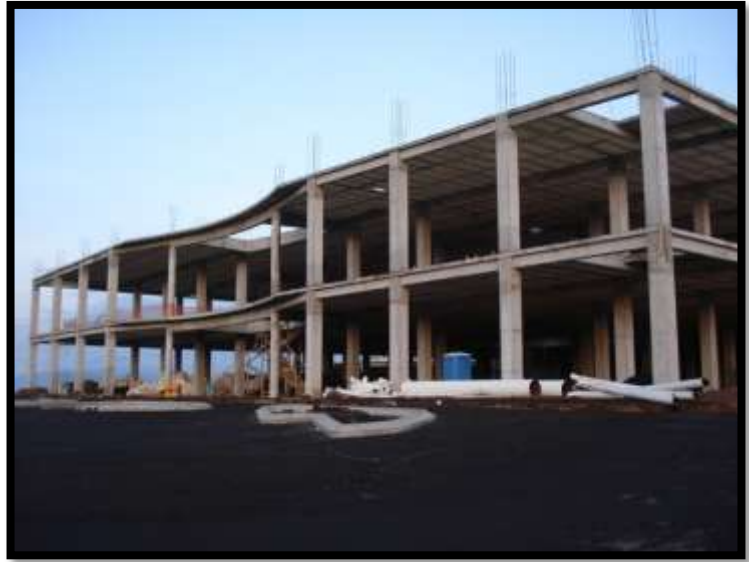
25. Estructura de Centro Comercial Altozano a base de Concreto Armado
