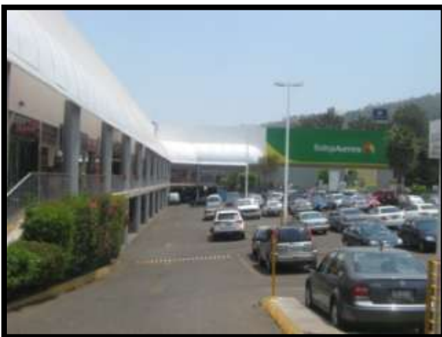
108. Vista lateral de la Fachada de la Plaza Comercial.
