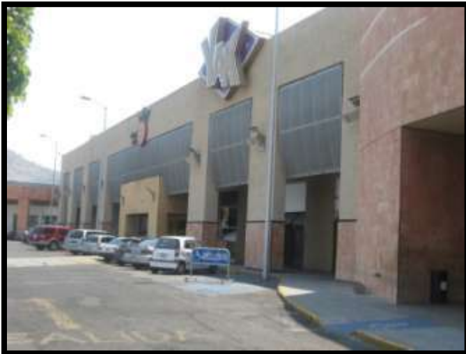
112. Fachada Principal de acceso
