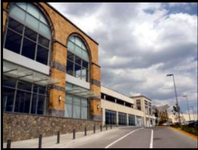
119. Fachada lateral del Complejo lateral.
