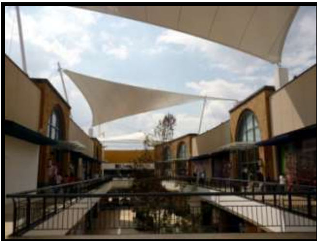
120. Puente de conexión en el corredor comercial.
