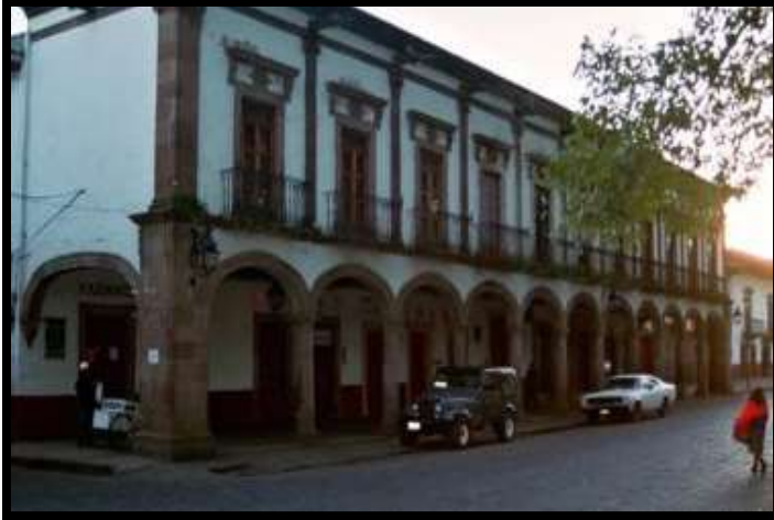
09. Portal Allende Plaza Vasco de Quiroga Pátzcuaro.
