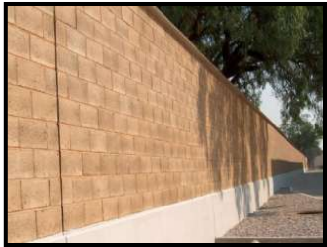
30. Muro Exterior Block Hueco Aparente
