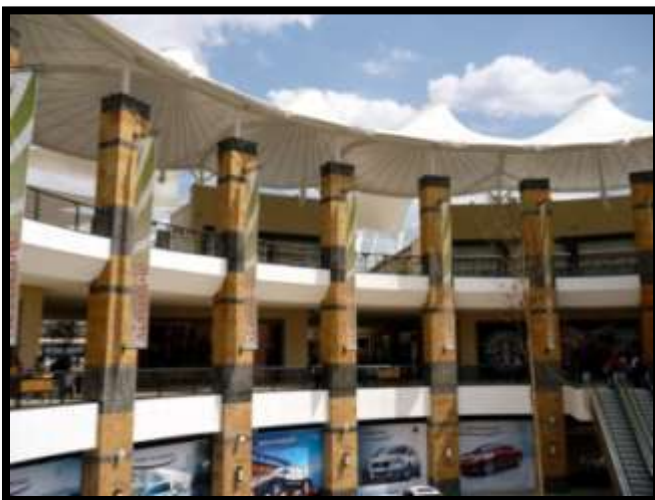
121. Vestíbulo Principal Oval de la Plaza.
