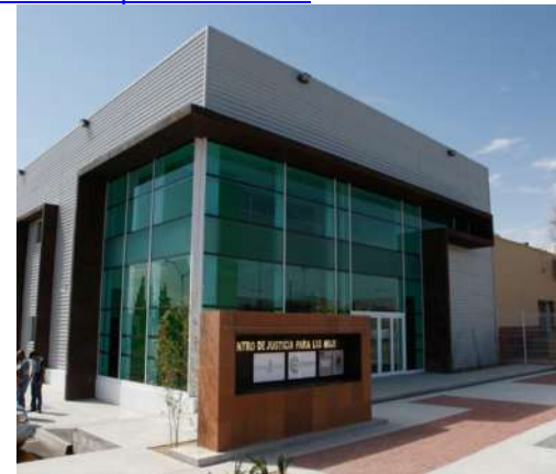
Fig. 11 Fachada principal del edificio. En ciudad Juárez chihuahua. En
