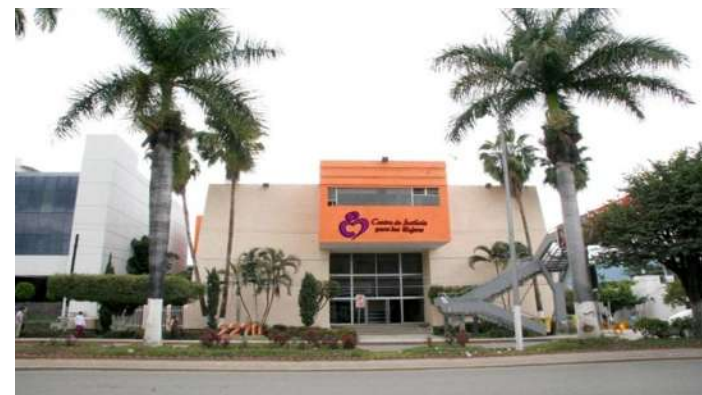
Fig. 9 Fachada principal del Centro de Justicia de Tuxtla Gutiérrez de Chiapas. En
