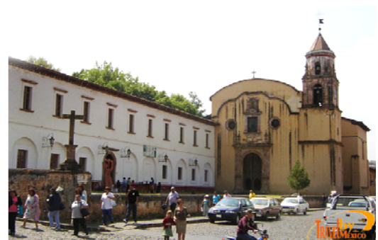
Ilustración 92 Desnivel de 1.50m para acceso principal a casa de la cultura. http://www.patzcuaro-web.com/03/03cuca01.htm
