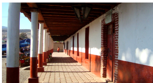
Ilustración 43 Estado actual de fachada con colores típicos en la región
