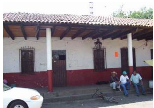
Ilustración 56 Desnivel de 50cm de la vialidad principal a nuestro acceso.
