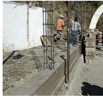
Ilustración 65 Anclaje de castillos en cadena. Idem
