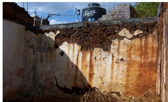
Ilustración 46 F3 Muro hecho de adobe y piedra aplanado con cal y cadena de cerramiento de concreto armado.
