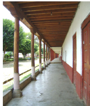
Ilustración 79 Viguera de madera en plafón. http://skyscraper.talkwhat.com/view/QgAEmNEmNQgAqYeqYe.html
