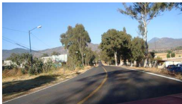
Ilustración 29 Tramo de carpeta asfáltica en vialidad principal Vasco de Quiroga. Acceso a Capula desde la ciudad de Morelia.
