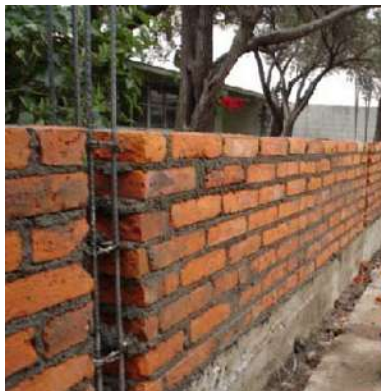
Ilustración 64 Colocación de tabique aparejo largo. http://www.aguascalientes.gob.mx/transparencia/calidad/sop/Obras/ReportesVarios/fotostransp.asp?StrIdContrato=3750
