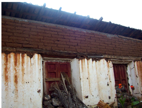
Ilustración 50 F1 Muro interior de fachada hecho de adobe, con vigas intermedias de madera y aplanado en algunas partes con cal.
