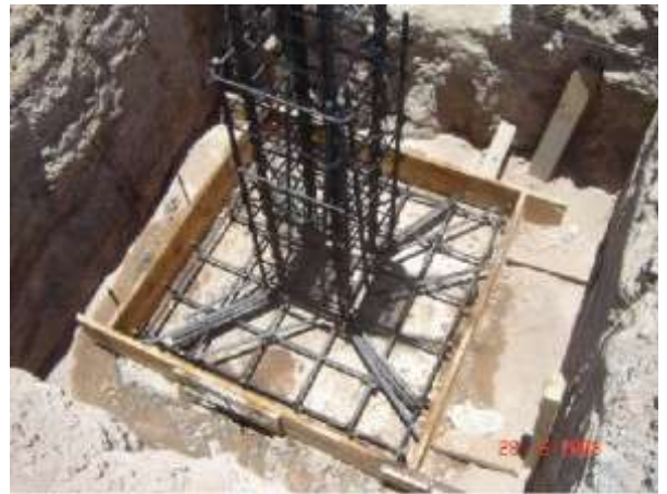
Ilustración 62. Armado de zapata aislada. http://aldoarqangel.blogspot.mx/2009/03/quiere-s-construir-tu-propia-casa-esta.html
