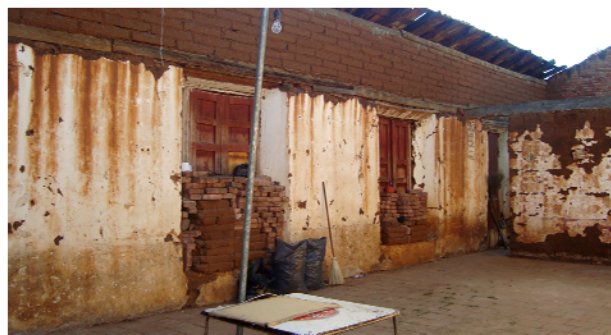
Ilustración 42 Muro de adobe de fachada existente
