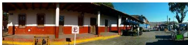
Ilustración 30 Av. Principal Francisco I Madero acceso principal a nuestro terreno.
