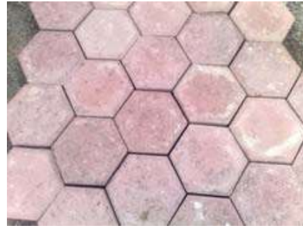
Ilustración 74 Colocación de adoquín hexagonal. http://www.prefabricadostecnoblock.com.mx/productos/adoqu%C3%ADn/
