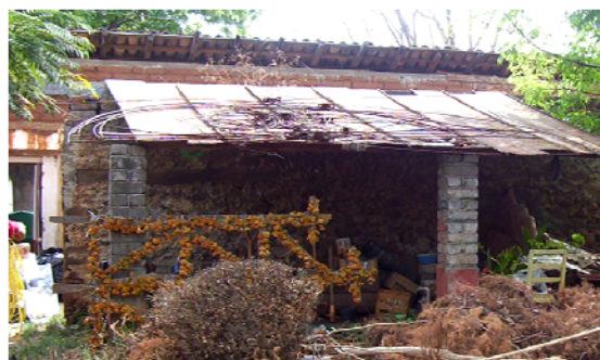
Ilustración 47 F4 Muro divisorio de adobe y piedra, también se pueden observar 2 columnas de tabicón que soportan un techo de lamina.
