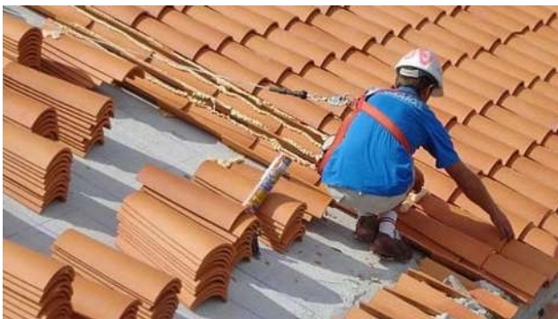
Ilustración 69 Colocación de teja en losa inclinada. idem
