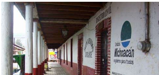
Ilustración 53 Fachada principal existente en terreno que se tendrá que respetar.
