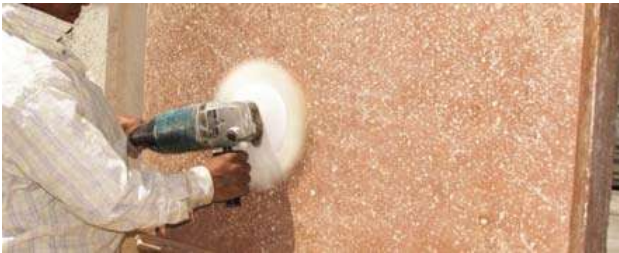
Ilustración 72 Acabado esmerilado en húmedo con pulidora. http://euroton.com.mx/?p=4011
