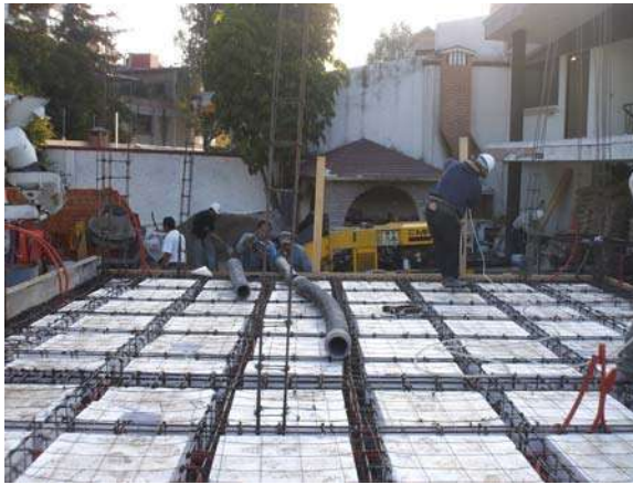
Ilustración 68 Armado de losa reticular. http://todoarquitecturadisenoconstruccion.blogspot.mx/2013/01/losa-reticular.html
