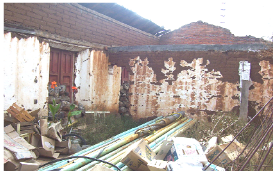
Ilustración 45 F2 Muro divisorio interior, hecho de adobe y piedra con una cadena de cerramiento de concreto.
