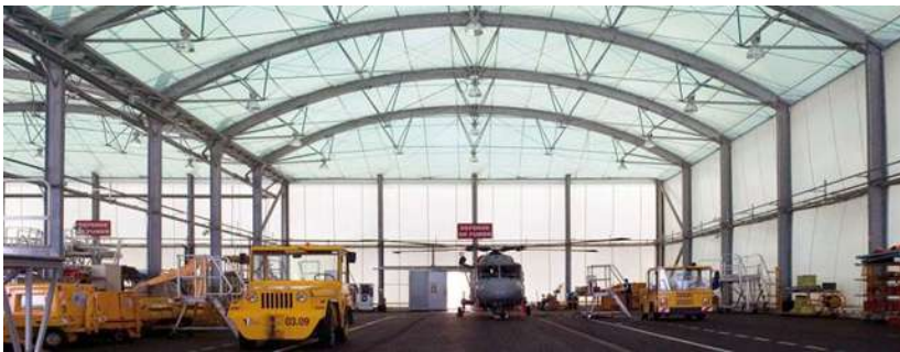
Fig. G 14 Estructura de acero completamente desmontable.
