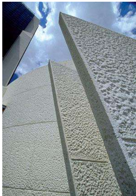
Fig. E 3 concreto en construcción.
