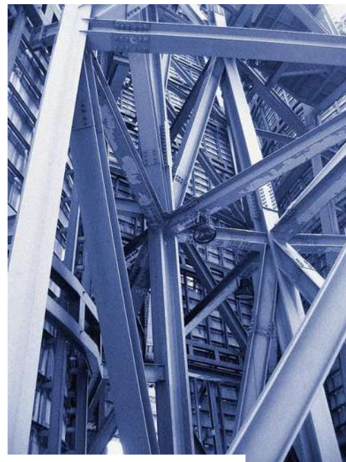
Fig. E1 Estructura de acero.
