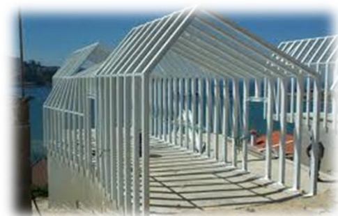
Fig. G 6 Estructura de acero, material contemporáneo además de ser muy ligero.
