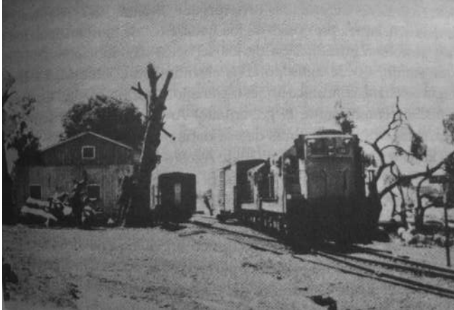
Foto: 39, Estación de ferrocarril. Irimbo, Historia de un pueblo.
