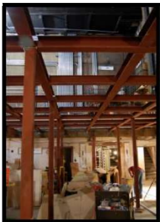
Imagen 70: Vigas de acero
