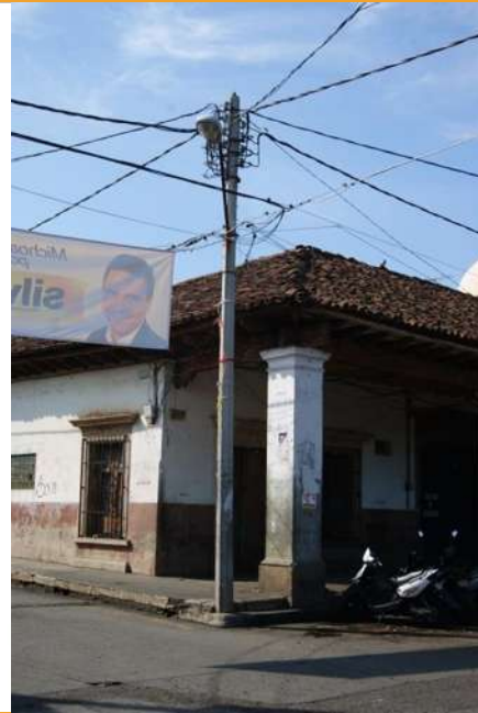
Foto 14. Cableado aéreo y lonas de propaganda que ocasionan caos visual.
