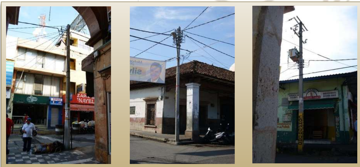
Imagen 47. Postes de concreto para tendido eléctrico e iluminación pública y con transformador. Fotografía tomada por el autor.
