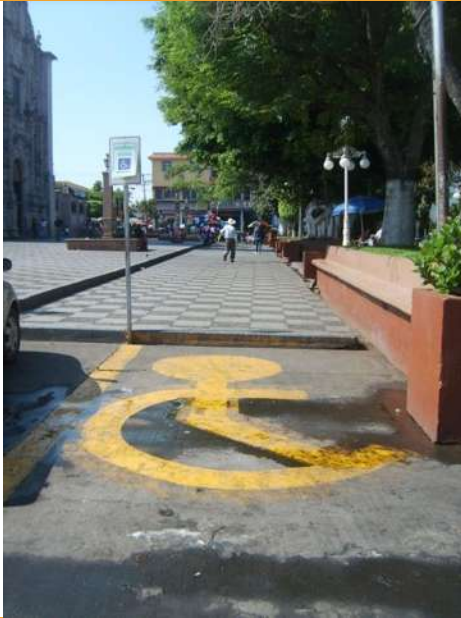
Foto 1. Se tienen espacios especiales destinados para el estacionamiento de discapacitados, mas no en todos se cuenta con rampa de acceso.
