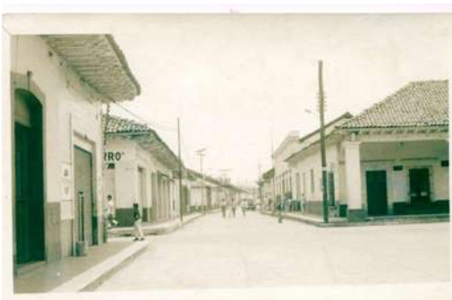
Imagen 51. Vista parcial de características constructivas. Fotografía anónima.
