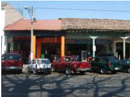
Imagen 41. Sistemas constructivos de techumbres y relación de vano-macizo. Fotografía tomada por el autor.
