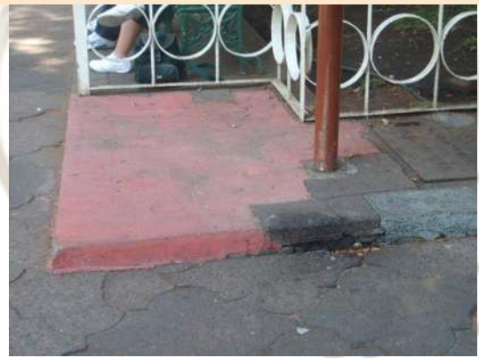
Foto 4. Resanes con materiales diferentes a los originales.
