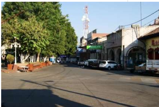
Imagen 34. Pavimento de concreto en calles. Fotografía tomada por el autor.
