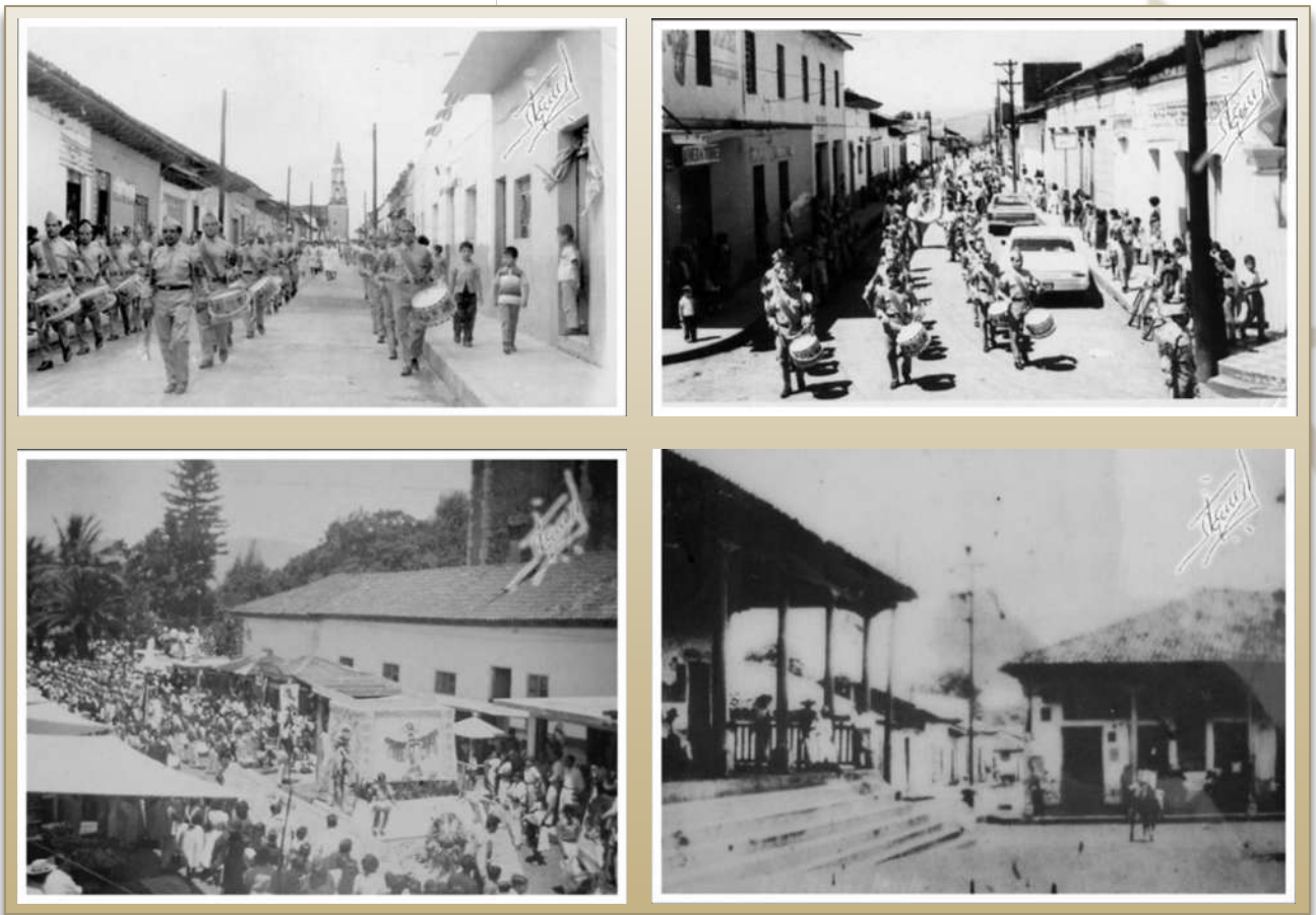
Imagen 52. Diferentes vistas de las viviendas ubicadas en las calles aledañas al centro de la Ciudad, en las que se pueden apreciar características formales y constructivas generales en la localidad. Fotografías tomadas por Alfonso Morales.
