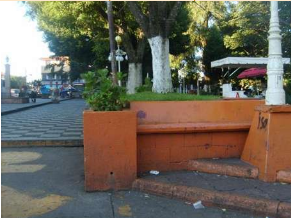
Foto 17. Obstrucción del espacio de bancas con farolas de iluminación de la plaza.
