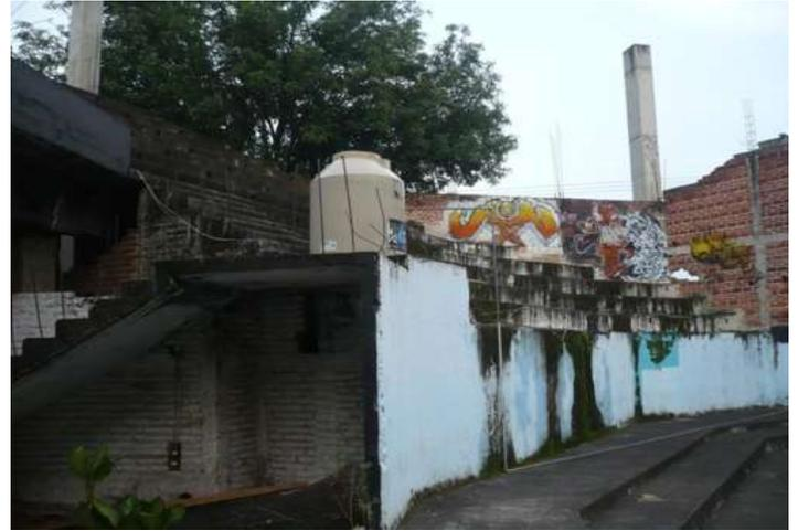
**Ilustración 6.** Humedad en muros y pisos, puntas de varillas oxidadas, muros de tabique sin recubrimiento; son aspectos de deterioro del inmueble de la Casa de la Cultura. © Navarrete, a 20/ 8 /2010.
