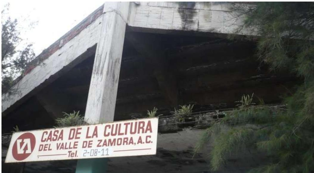
**Ilustración 4.** Único acceso al inmueble, presenta humedad, vegetación y varillas sin recubrimiento. © Navarrete, a 20/ 8 /2010.
