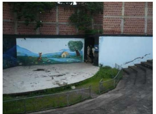
**Ilustración 7-12.** De izquierda a derecha. Fachada poniente del inmueble inacabada, con vidrios rotos y humedad, acceso al inmueble presenta humedad, recubrimientos en mal estado y de mala calidad, anfiteatro de la casa de la cultura, presenta humedad, varillas descubiertas mohosas, vegetación silvestre entre otras cuestiones . © Navarrete, a 20/ 8 /2010.
