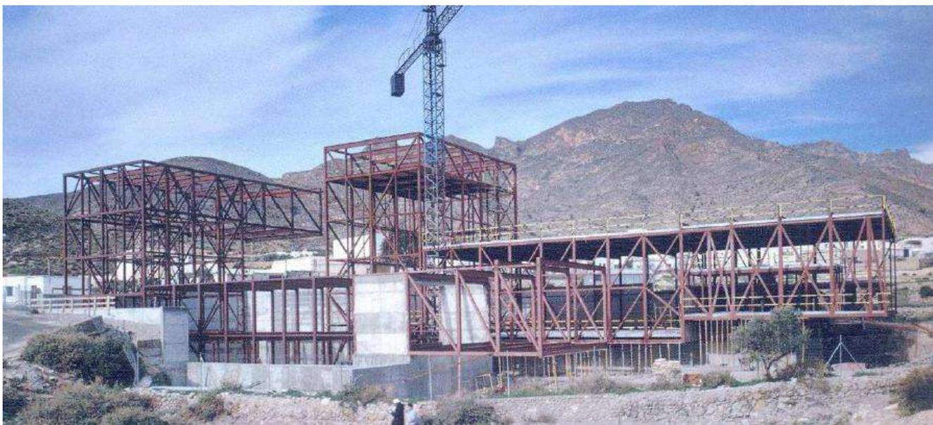
Ilustración 56. Estructuración del inmueble con perfiles IPR<sup>23</sup>
