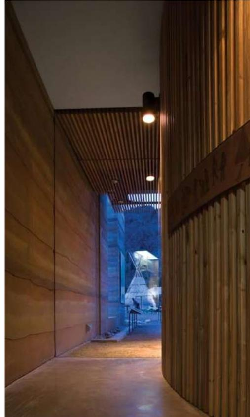
Ilustración 46 y 47. Pasillos y accesos donde se observa el acabado logrado por el uso del tapial<sup>17</sup>
