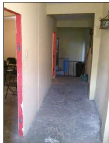
Foto 50: Vista general del pasillo de planta alta. Fuente propia.
