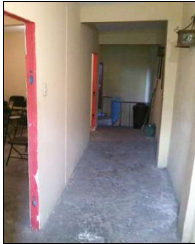
Foto 14: Vista del pasillo que da acceso al primer salón de clase, partiendo del cubo de escaleras.
