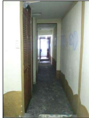
Foto 15: Vista del pasillo que da acceso a la cocina y al resto de los salones de clase.
