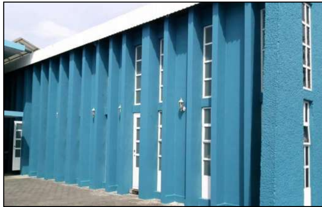
Foto 40: vista lateral de la nave
