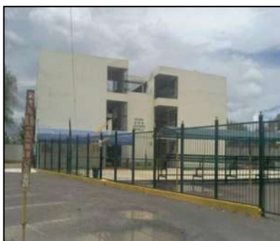
Foto 21: Vista del acceso principal y parte del estacionamiento del colegio. Fuente propia.
