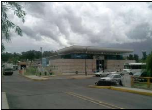
Foto 19: Vista general de la central camionera norte, ubicada al norte del predio.
