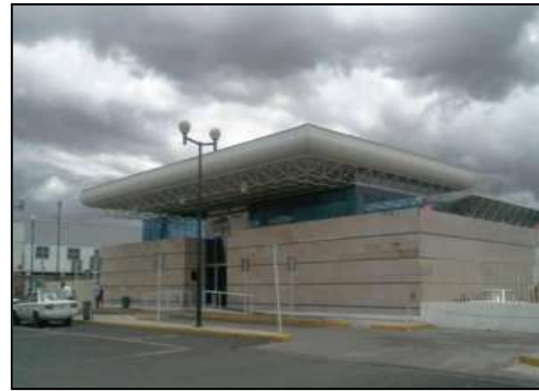
Foto 20: Vista del acceso peatonal de la central camionera norte.
