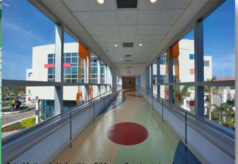
Foto 12: Hospital Infantil Joe DiMaggio, Puente peatonal
