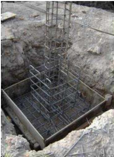
ILUSTRACIÓN 40 – armado de zapata [imagen]. (2012). - [en línea] disponible en: [http://1122abarbaramagalay.blogspot.com/2011/03/cimentaciones\\_3944.html](http://1122abarbaramagalay.blogspot.com/2011/03/cimentaciones_3944.html)
