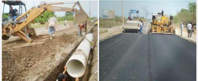
ILUSTRACIÓN 34 – trabajos de drenaje y pavimentación. [Imagen]. (2012). [en línea] disponible en: <http://davidarincon.com/obra%20civil.html/>
