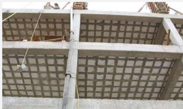
ILUSTRACIÓN 45 – losa reticular, materiales de construcción, [imagen]. (2012). - [en línea] disponible en: [http://www.poliestirenosmexico.com/?page\\_id=53](http://www.poliestirenosmexico.com/?page_id=53)
