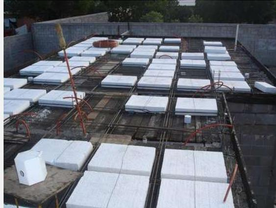
ILUSTRACIÓN 44 – losa reticular, materiales de construcción, [imagen]. (2012). - [en línea] disponible en: <http://www.flickr.com/photos/ezproyect/4790750571/>
