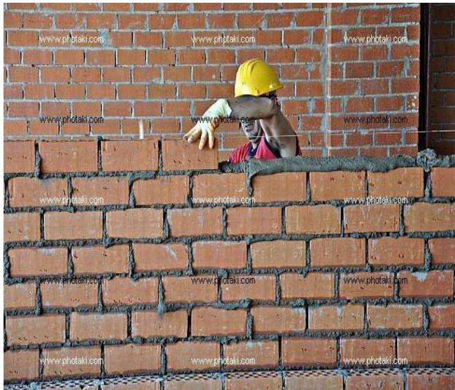
Fig.13.- Unión de tabiques con mortero en la construcción de un muro, [www.photaki.es](http://www.photaki.es), 05 de Agosto de 2012.
