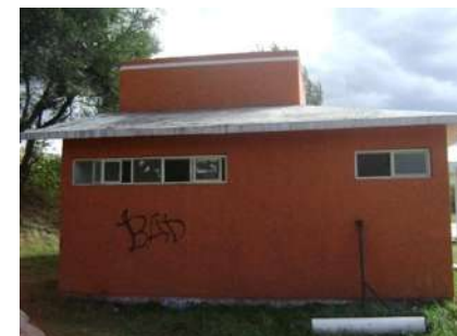
Foto 1. Sanitarios, tomada por Rodolfo Barajas García. [05/noviembre/2009].
