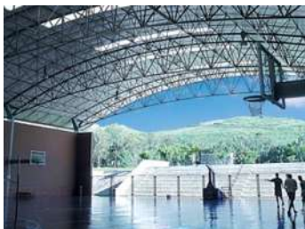
Foto 33. Centro Deportivo Universitario en Gómez Palacio – Durango, editada por Rodolfo Barajas García [http://techosymantenimientos.com/139779_PERFILES-ENGARGOLADOS.html (21/octubre/2011)].
