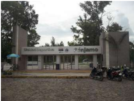
Foto 18. Acceso, tomada por Rodolfo Barajas García (19/agosto/2012).
