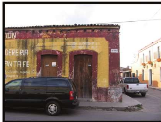
Fig. 04 Casa en calle Madero. Fuente: Juan M. Moreno Ramírez
