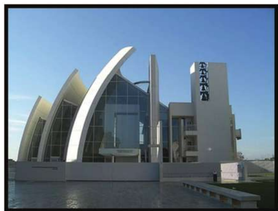
Fig. 38 3d fachada principal. Fuente: http://es.wikiarquitectura.com/index.php/Archivo:11jub.jpg
