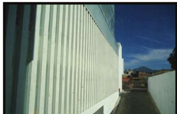
Fig. 10 Rampa hacia el sótano. Fuente: Juan M. Moreno Ramírez
