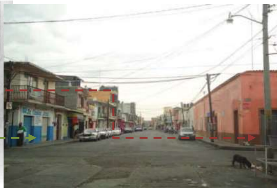
Fig. 16 Calle Ocampo actual. Fuente: foto tomada por Juan M. Moreno Ramírez
