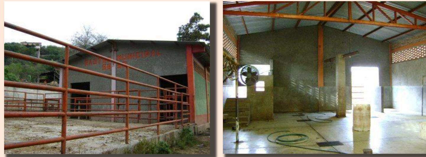
(22): EXTERIOR E INTERIOR DEL RASTRO MUNICIPAL DE JUNGAPED DE JUÁREZ FUENTE: PROGRAMA MUNICIPAL DE DESARROLLO URBANO DE JUNGAPED.
