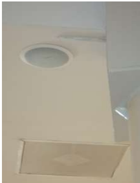
Fig. 182, Detalle bocina plafón y salida aire
