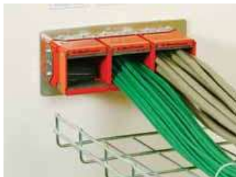
Fig. 256, Detalle ducto para cables señal
