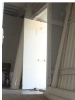
Fig. 166, Salida de emergencia
