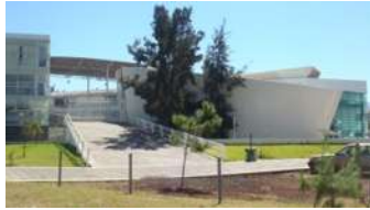
Fig 01, Auditorio de la Facultad de Arquitectura
