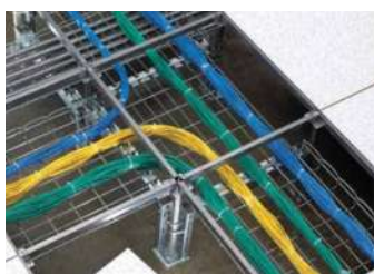
Fig. 257, Detalle esquina ducto señal
