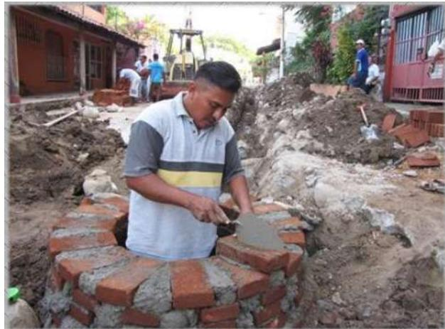
ILUSTRACIÓN 20: RENOVACIÓN DE RED SANITARIA EN ZIHUATANEJO
