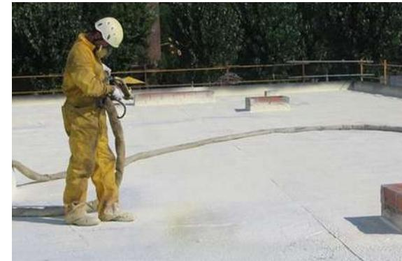
Ilustración 24: Terminado con espuma poliuretano
