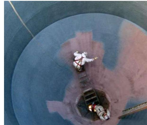
Ilustración 22: Aplicación de pintura epóxica
