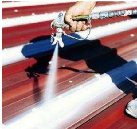
Ilustración 23: Aplicación de espuma de poliuretano
