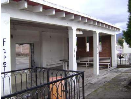
Vista Interior del Acceso
