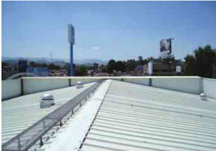
Imagen 20-Cubierta de nave industrial, Fuente: cuauhtemoc-distritofederal.olx.com.mx
