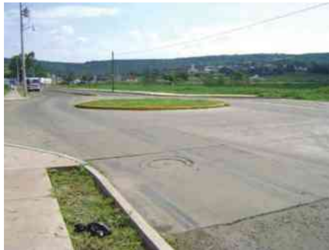
Imagen 13-Localizacion de red agua potable y drenaje, Fuente: fotografía tomada por el autor.
