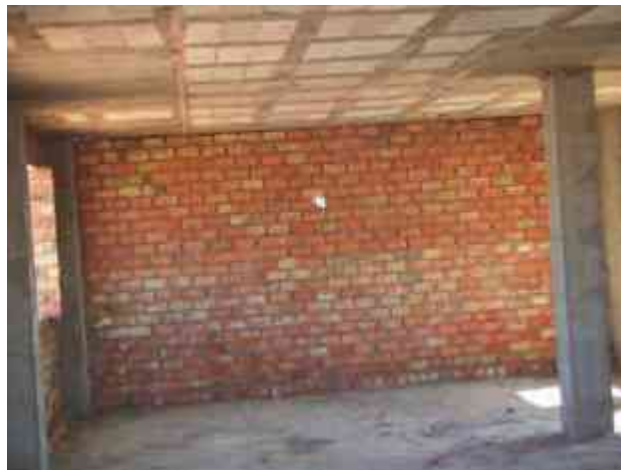
Imagen 17-Muros de tabique rojo, Fuente: aparejador.blogia.com
