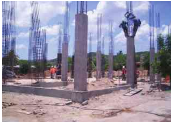
Imagen 22-Columnas de concreto armado, Fuente: www.aguascalientes.gob.mx
