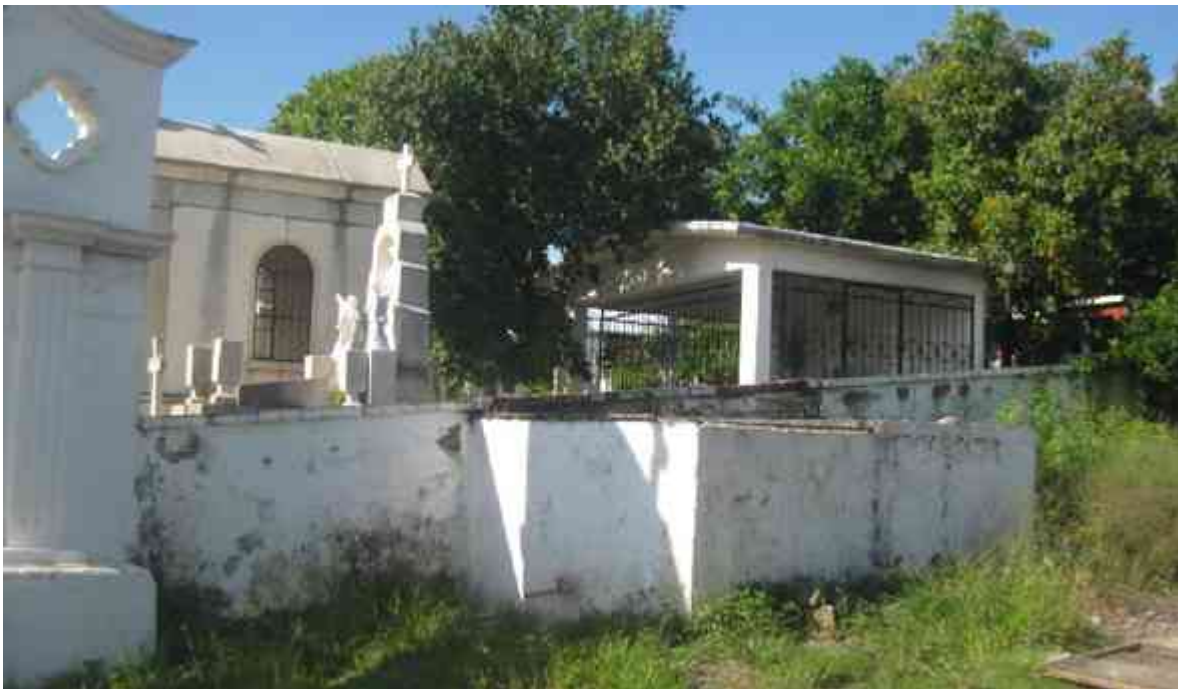
Imagen no . 4 Vista de la cisterna abierta que es el único abastecimiento de agua para el panteón actual.
