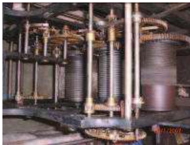
Foto N° 4. Rollos que sostienen las pesas mediante tensores de acero.
