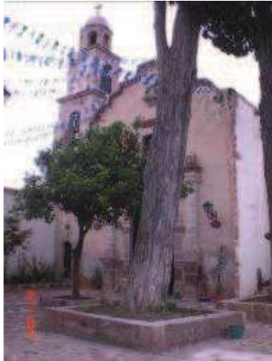
Foto N° 1. Exterior del hospital de la Huananchita
