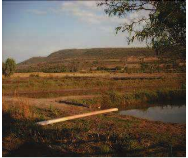
Foto N°20. Los actuales estanques son llenados con el agua del río que divide el terreno.
