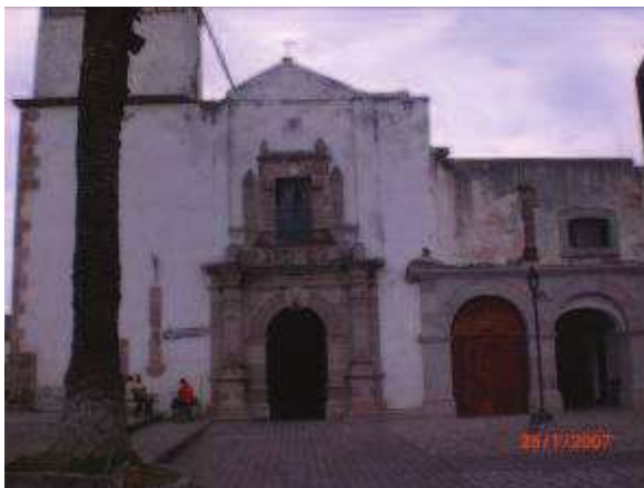
Foto N° 9. Parroquia de Chucándiro construida por Fray Felipe de V. Actualmente se encuentra en reparación.
