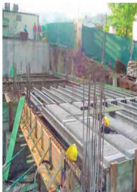
Ilustración 60 Amado losa de vigueta y bovedilla obtenido de www.google.com/images
