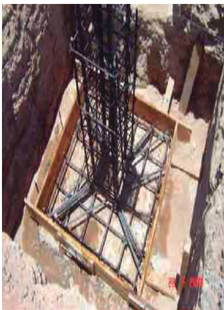
Ilustración 59 Armado de zapata, obtenida de www.argys.com
