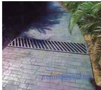
Ilustración 64 Piso terminado de concreto estampado, obtenido de www.google.com/images
