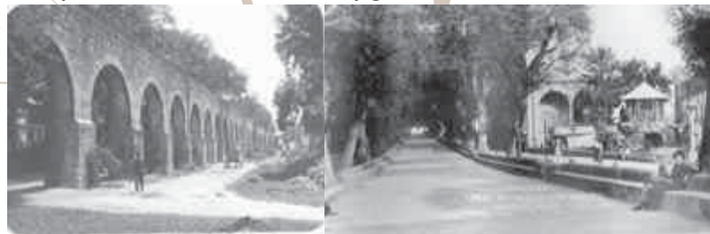
Fig. 27: Acueducto y Calzada Fray Antonio de San Miguel de la ciudad de Morelia. www.moreliaturismo.webs.com y www.espejel.com/nueva/gale.html
