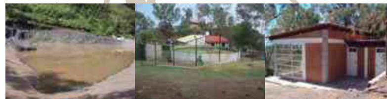
Fig. 53.- Bordo de captación de agua de lluvia, oficinas, tanque de almacenamiento pluvial, sala audiovisual y sanitarios http://www.cerropunhuato.com/infraestructura.html
