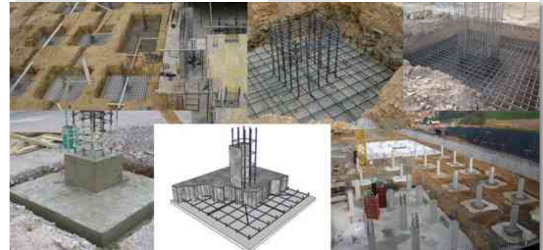
Imagen 75, Zapatas aisladas, google imágenes.
