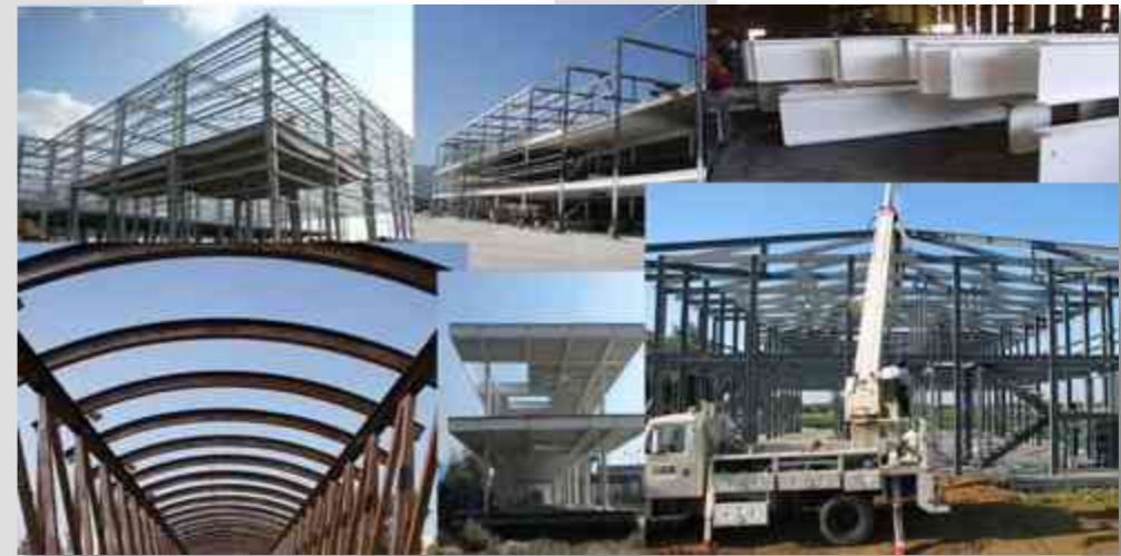
Imagen 77, Estructura de acero, google imágenes.
