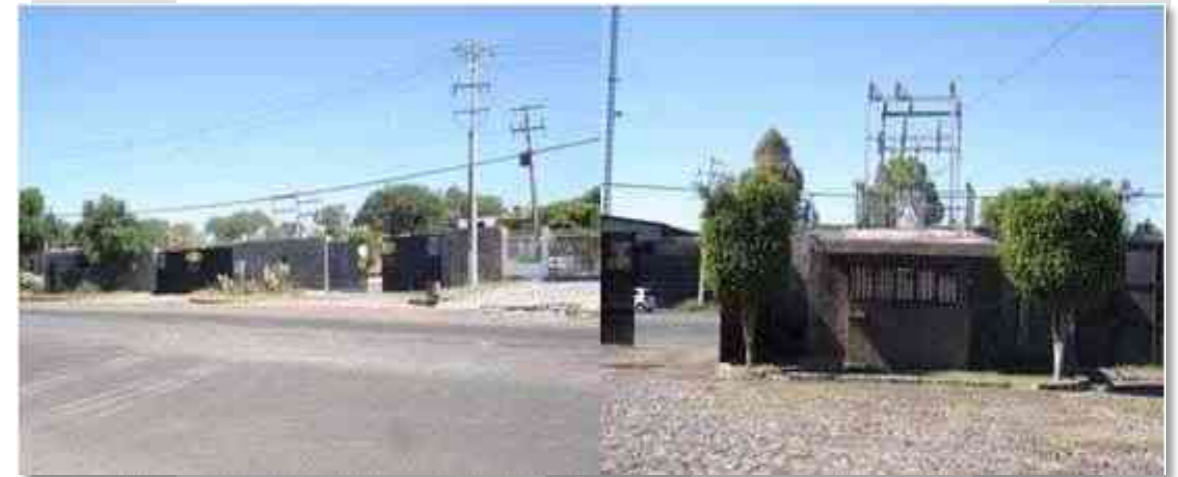
Imagen 67/68, Acceso/Planta de Energía Eléctrica, Said Alberto.
