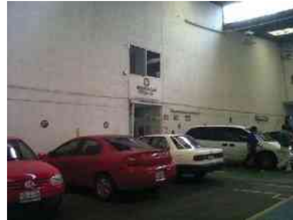
Fotografía 4 Se ubica dentro de un estacionamiento publico al centro de la ciudad.
