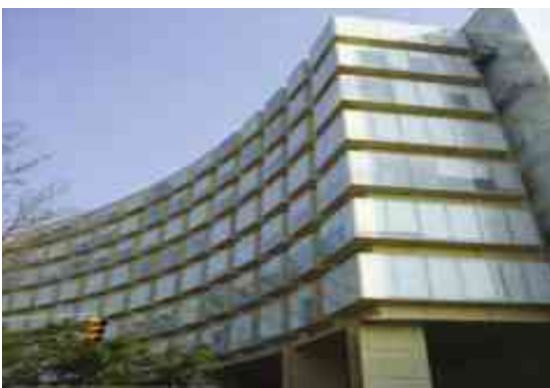
IMAGEN 142: CENTRO COMERCIAL ANTARA TOMADA DE: HTTP://WWW.ARQUITOUR.COM/ANTARA-JAVIER-SORDO-MADALENO/2009/05/
