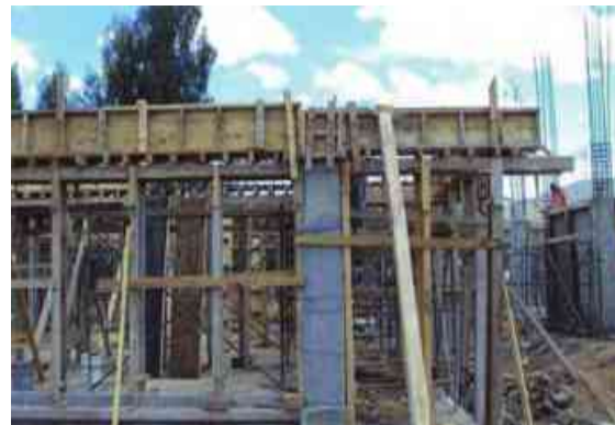
IMAGEN 71: CIMBRADO DE LAS TRABES TOMADO DE: PROYECTO CONALEP EN SANTIAGO MARAVATIO GTO
