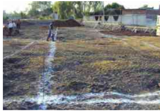
IMAGEN 57: TRAZO DEL TERRENO TOMADO DE: CONSTRUCCIÓN DEL CONALEP EN SANTIAGO MARAVATIO GTO.
