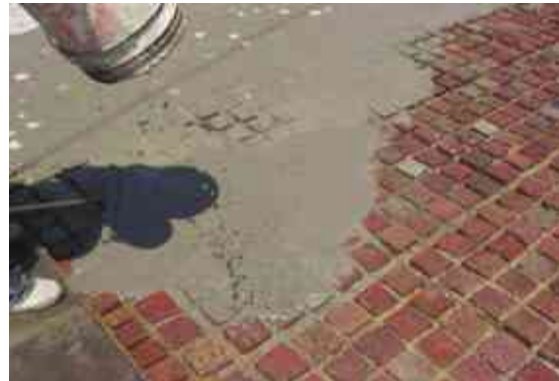
IMAGEN 97: LECHADA DE CEMENTO - ARENA TOMADO DE: HTTP://MOREIRAMKM.COM/WORK/OTRASPIEDRAS_ESP.HTML
