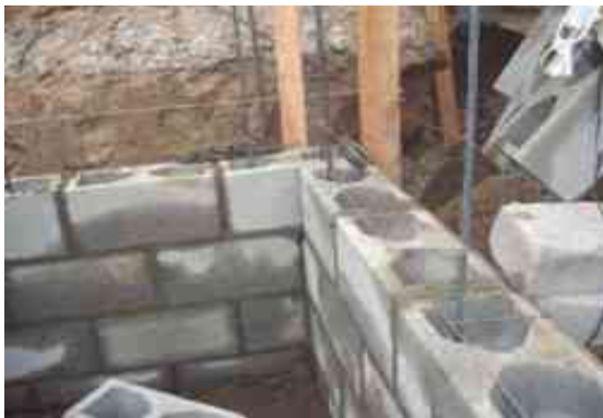
IMAGEN 79: MURO DE BLOCK HUECO CON ESCALERILLA TOMADO DE: SUB PROCURADURÍA DE IRAPUATO GTO
