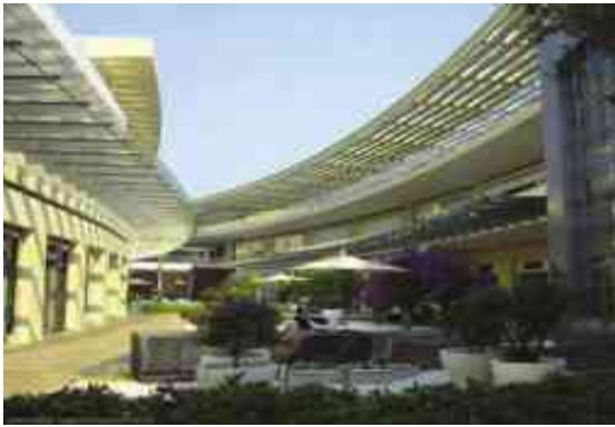
IMAGEN 141: CENTRO COMERCIAL ANTARA TOMADA DE: HTTP://WWW.ARQUITOUR.COM/ANTARA-JAVIER-SORDO-MADALENO/2009/05/
