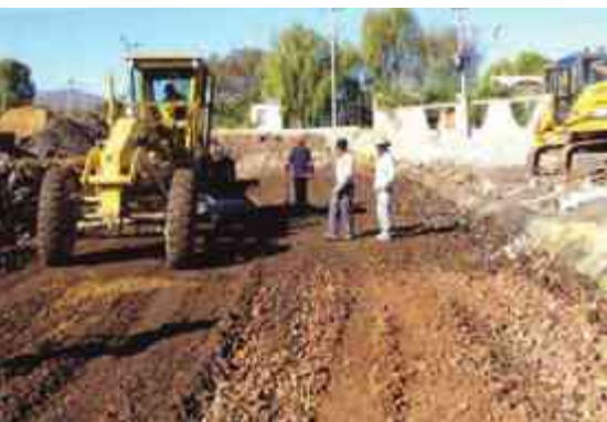
IMAGEN 60: MEJORAMIENTO CON TEZONTLE-TEPETATE 70/30 TOMADO DE: CONSTRUCCIÓN DEL CONALEP EN SANTIAGO MARAVATIO GTO.
