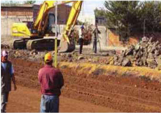
IMAGEN 56: NIVELACIÓN DEL TERRENO CON NIVEL ÓPTICO Y EQUIPO TOPOGRÁFICO TOMADO DE: CONSTRUCCIÓN DEL CONALEP EN SANTIAGO MARAVATIO GTO.
