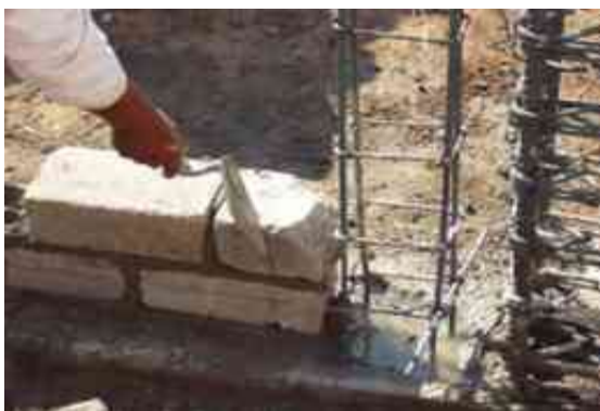
IMAGEN 82: COLOCACIÓN DEL TABICÓN TOMADO DE: CONSTRUCCIÓN DE LA SUB PROCURADURÍA DE IRAPUATO GTO
