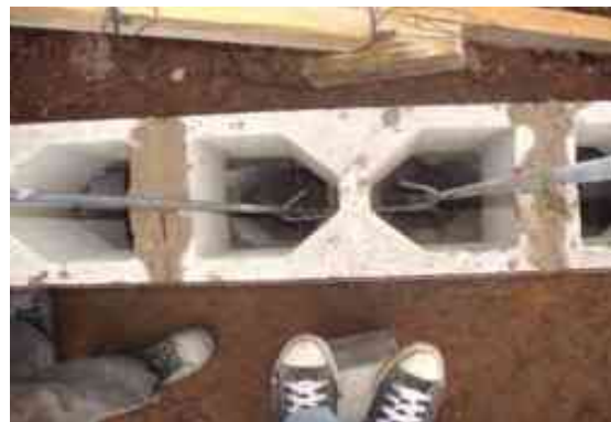
IMAGEN 80: ARMADO CASTILLO EN EL BLOCK TOMADO DE: SUB PROCURADURÍA DE IRAPUATO GTO
