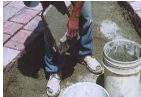
IMAGEN 94: COLOCACIÓN DEL PÓRFIDO TOMADO DE: HTTP://MOREIRAMKM.COM/WORK/OTRASPIEDRAS_ESP.HTML
