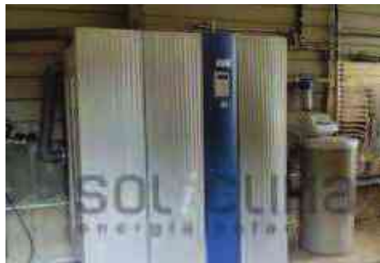
IMAGEN 117: TRATAMIENTO DE AGUAS GRISES TOMADO DE: HTTP://WWW.SOLCLIMA.ES/APLICACIONES/4-TRATAMIENTO-DE-AGUAS/96-TRATAMIENTO-DE-AGUAS-GRISES.HTML
