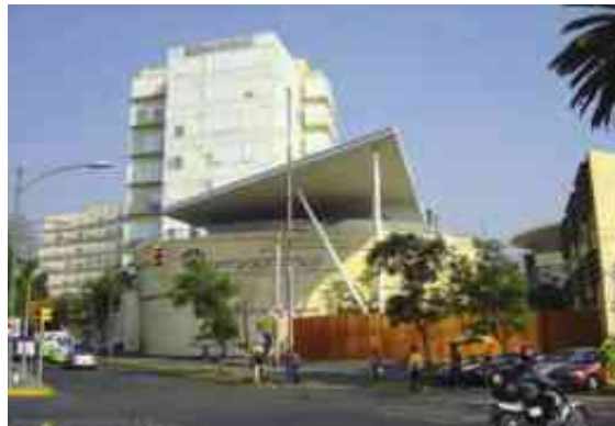
IMAGEN 140: CENTRO COMERCIAL ANTARA TOMADA DE: HTTP://WWW.ARQUITOUR.COM/ANTARA-JAVIER-SORDO-MADALENO/2009/05/
