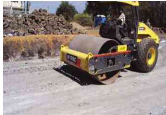
IMAGEN 59: COMPUTACIÓN DEL TERRENO NATURAL TOMADO DE: CONSTRUCCIÓN DEL CONALEP EN SANTIAGO MARAVATIO GTO.
