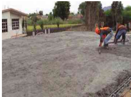
IMAGEN 77: COLADO DE LOSA TOMADO DE: CONSTRUCCIÓN CONALEP DE SANTIAGO MARAVATIO GTO
