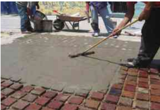
IMAGEN 96: LECHADA DE CEMENTO - ARENA TOMADO DE: HTTP://MOREIRAMKM.COM/WORK/OTRASPIEDRAS_ESP.HTML
