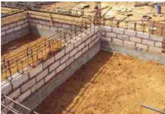
IMAGEN 67: ARMADO DE CADENAS Y CASTILLOS TOMADO DE: PROYECTO CONALEP EN SANTIAGO MARAVATIO GTO.
