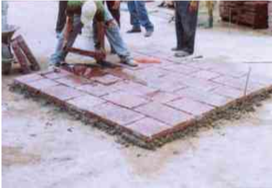
IMAGEN 92: COLOCACION DEL PORFIDO TOMADO DE: HTTP://MOREIRAMKM.COM/WORK/OTRASPIEDRAS_ESP.HTML
