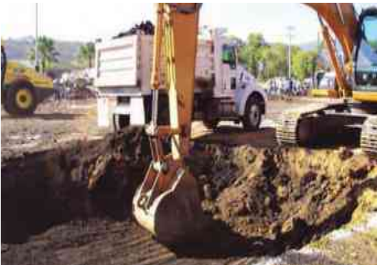
IMAGEN 58: EXCAVACIÓN, CON EXCAVADORA DE ORUGA TOMADO DE: CONSTRUCCIÓN DEL CONALEP EN SANTIAGO MARAVATIO GTO.
