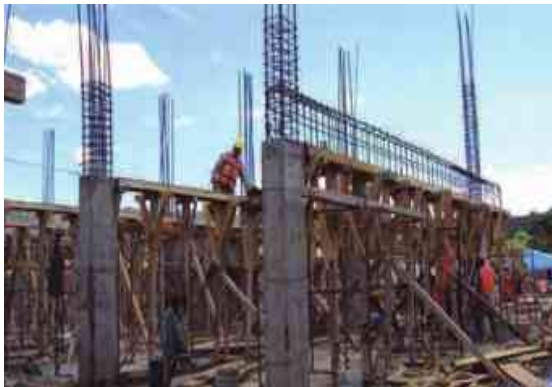
IMAGEN 70: ARMADO TRABE DE CONCRETO REFORZADO TOMADO DE: PROYECTO CONALEP EN SANTIAGO MARAVATIO GTO
