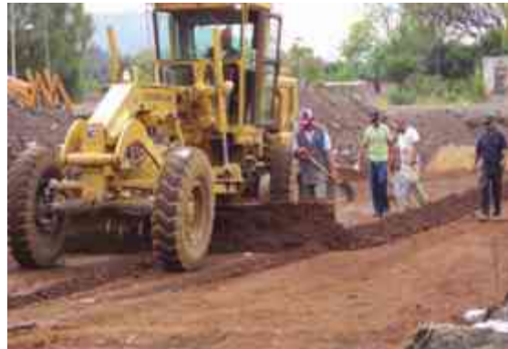
IMAGEN 61: COMPACTACIÓN DEL TEPETATE 95% TOMADO DE: CONSTRUCCIÓN DEL CONALEP EN SANTIAGO MARAVATIO GTO.
