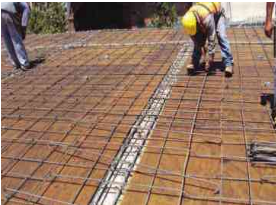
IMAGEN 76: ARMADO DE LOSA TOMADO DE: CONSTRUCCIÓN CONALEP DE SANTIAGO MARAVATIO GTO
