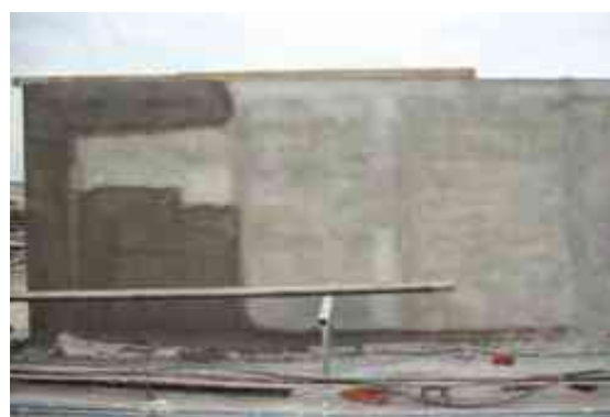
IMAGEN 83: MURO DE TABICÓN CON APLANADO TOMADO CONSTRUCCIÓN DE LA DE: SUB PROCURADURÍA DE IRAPUATO GTO
