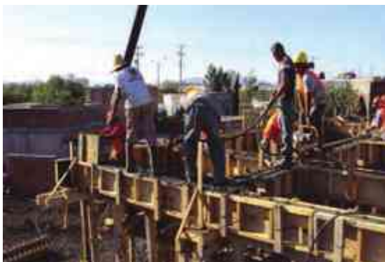
IMAGEN 72: COLADO DE LAS TRABES TOMADO DE: PROYECTO CONALEP DE SANTIAGO MARAVATIO GTO
