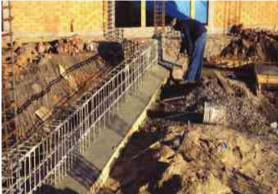
IMAGEN 65: ARMADO DE LA TRABA DE LIGA TOMADO DE: PROYECTO CONALEP EN SANTIAGO MARAVATIO GTO.
