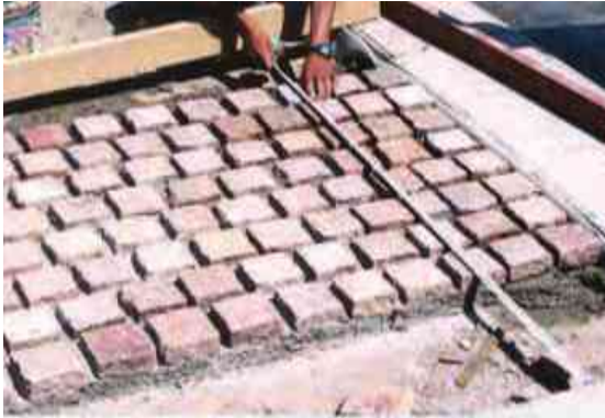
IMAGEN 95: JUNTEADO O ENBOQUILLADO TOMADO DE: HTTP://MOREIRAMKM.COM/WORK/OTRASPIEDRAS_ESP.HTML
