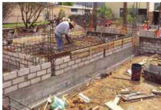
IMAGEN 68: COLADO DE CADENA DE DESPLANTA TOMADO DE: PROYECTO CONALEP EN SANTIAGO MARAVATIO GTO.
