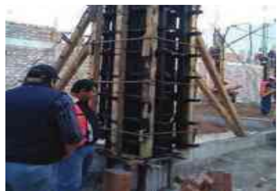
IMAGEN 64: COLUMNAS DE CONCRETO REFORZADO TOMADO DE: PROYECTO CONALEP EN SANTIAGO MARAVATIO GTO.
