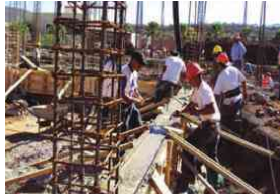
IMAGEN 66: COLADO DE LA TRABA DE LIGA TOMADO DE: PROYECTO CONALEP EN SANTIAGO MARAVATIO GTO.
