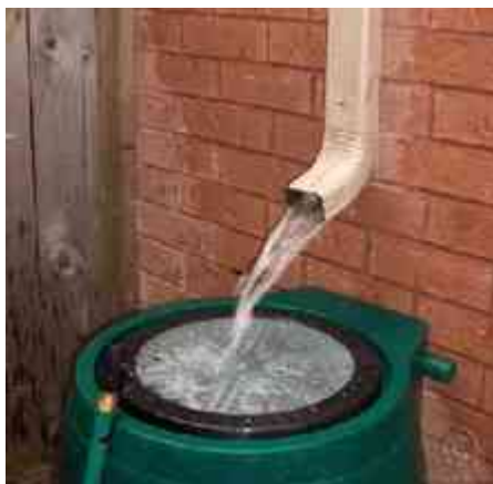
Imagen 25. Diseño de captación de aguas pluviales, http://www.google.com.mx
