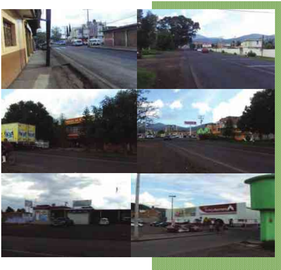
Ilustración 49: Vistas del contexto urbano de la salida Quiroga-Pátzcuaro
