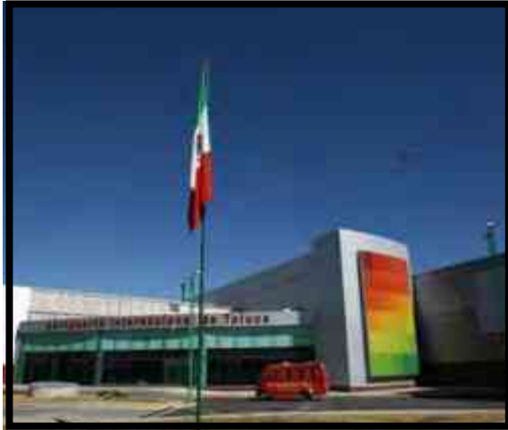
IMAGEN 5.12 TERMINAL AÉREA DEL AEROPUERTO INTERNACIONAL DE TOLUCA.
