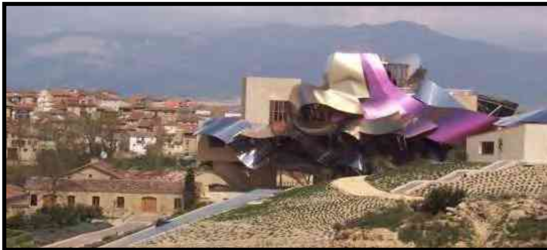
6.3 HOTEL DE LAS BODEGAS MARQUES DE RISCAL EL CIEGO, ESPAÑA, FRANK GHERY.
