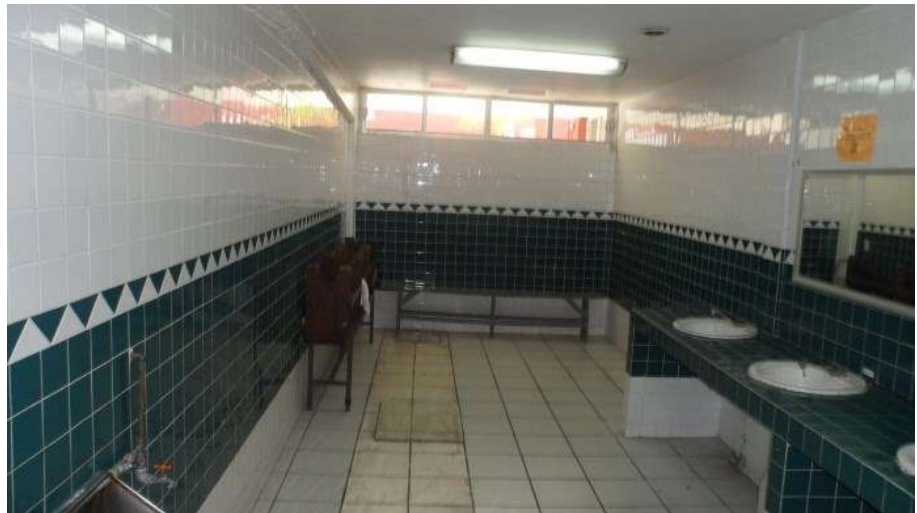
Fotografía 3.8.- Estación Central, León, Guanajuato, Baños, ArqYoy_F (2013), Archivo Personal
