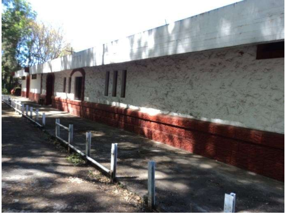
Fotografía 3.27.- Estación Bomberos 1, Leon, Guanajuato, Fachada principal, ArqYoy_F (2013), Archivo Personal.
