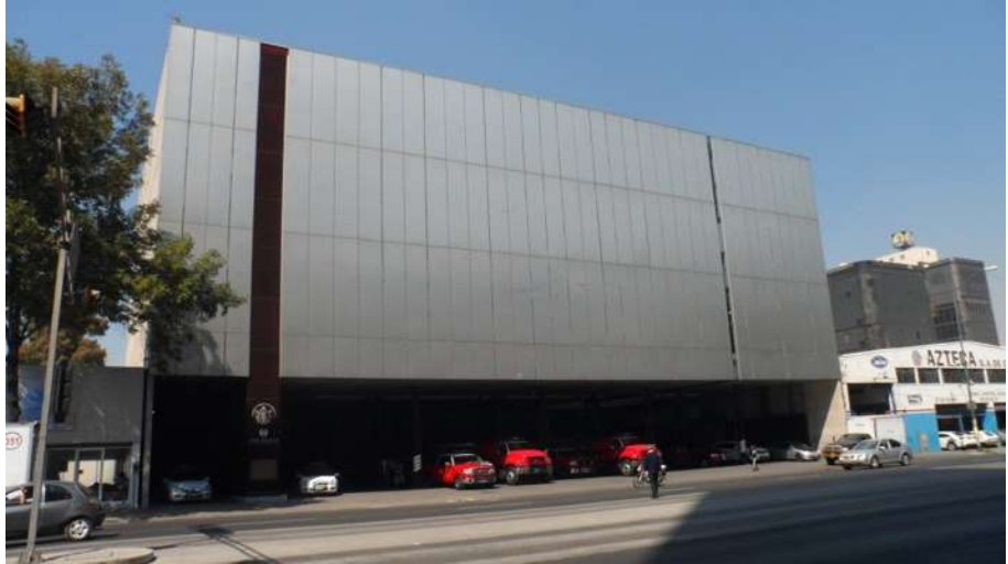
Fotografía 3.1.- Estación Ave Fénix, Distrito Federal, Delegación Fachada Principal 03, ArqYoy_F (2013), Archivo Personal
