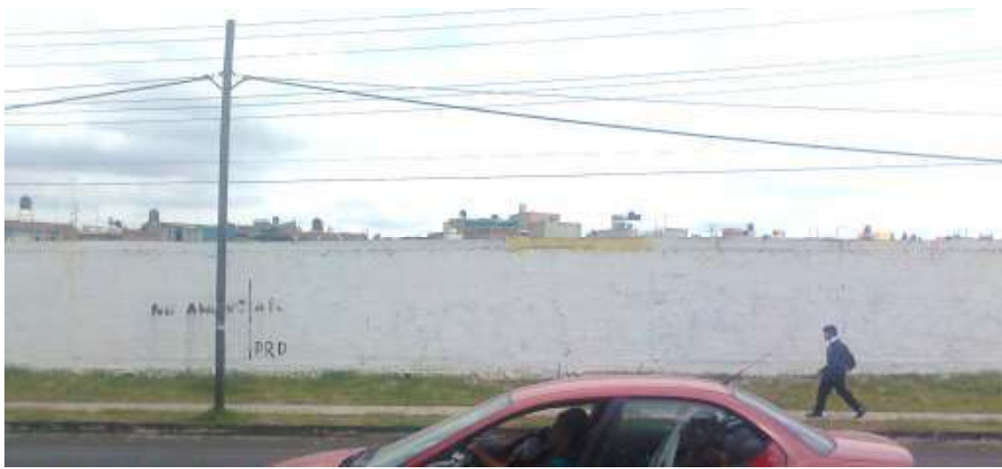
Imagen18. Muestra la barda perimetral con la que cuenta el predio
