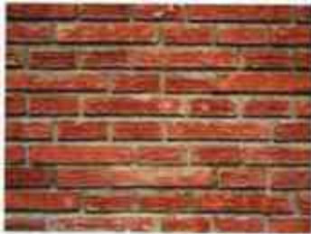
43. Muro de ladrillo rojo recocido, wikipedia1.wikispaces.com, consulta, mayo 2013
