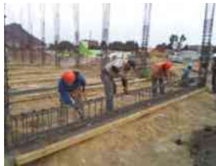
Unir zapatas con trabes de liga
