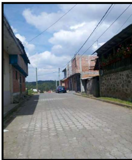
Imagen 42. Calle adoquinada. S. Galván H.
