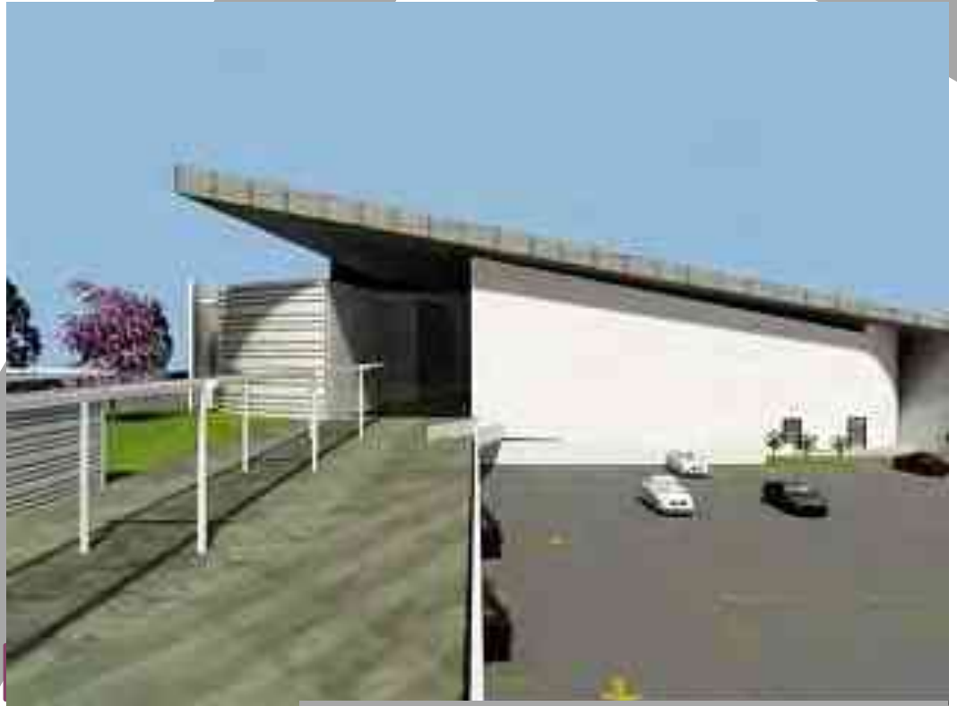
VISTA EXTERIOR DE AZA Y ESTACIONAMIENTO
