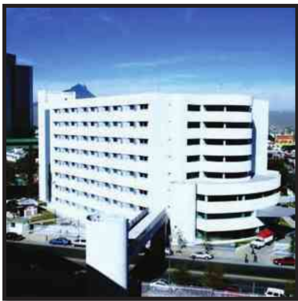
Imagen 7. Edificio de Residencia Universitaria en Monterrey.
