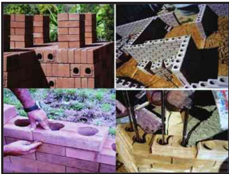
Imagen 19. Uso de ladrillos bloques con morteros y hierros cruzados para su calce y rellenos con poliuretano unificando toda la estructura transformando a todos los muros de una casa en una sola estructura.
