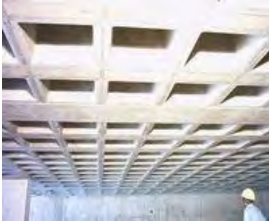
Imagen 38. Se retiraron los casetones como parte del diseño de la losa reticular. ARQHYS (2012). "Losa reticular". Santo Domingo, República Dominicana. www.arqhys.com, consulta: 11/2012.
