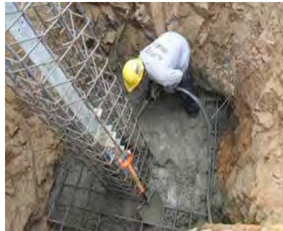
Imagen 39. El colado de la zapata de cimentación, con el uso de un vibrador de concreto para su compactación. Ortiz Amaya, Santiago (2013). "Zapata de cimentación". Morelia, Michoacán.
