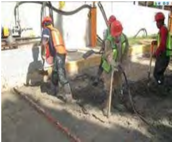
Imagen 40. Los trabajadores dispersan el concreto y otro de ellos lo compacta con un vibrador de concreto. Revista Construir (2012). "Vibrado del concreto de un firme". México, D.F. www.revistaconstruir.com , consulta: 11/2012.
