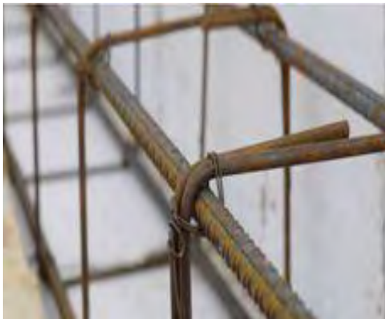
Imagen 37. Armado de un castillo, con el uso de alambre recocado y el alambón para los anillos. Ortiz Amaya, Santiago (2013). "Armado de Castillo". Morelia, Michoacán.
