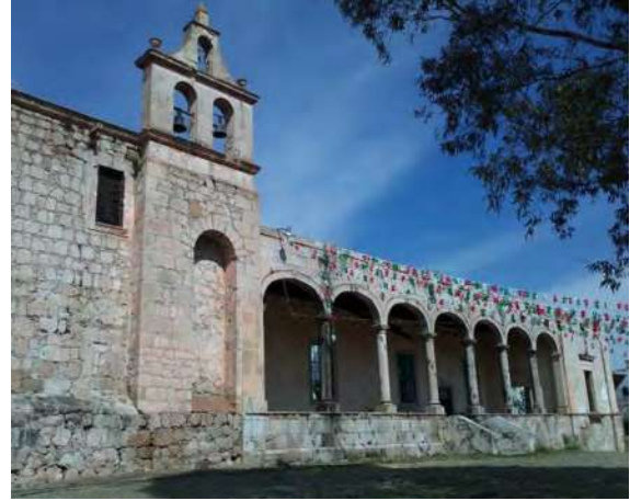
Imagen 26. La Ex Hacienda se encuentra deteriorada y la usan para realizar fiestas locales. Ortiz Amaya, Santiago (2012). "Ex hacienda de Guadalupe". Tarímbaro, Michoacán.
