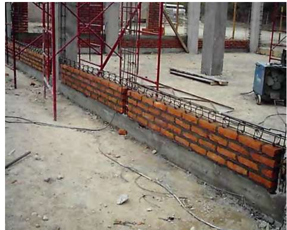
Imagen 36. Se ven las cadenas de desplante para iniciar el levantamiento del muro al interior del inmueble. Ortiz Amaya, Santiago (2012). "Cadena de desplante" . Morelia, Michoacán.
