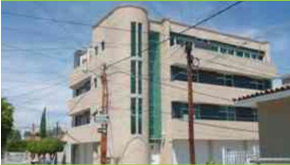
Fig. 40. Imagen Urbana V. Fotografía de la imagen urbana de la zona del terreno. Fotografía del autor.
