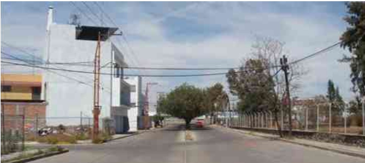
Fig. 33. Infraestructura Urbana I. En esta fotografía se puede apreciar la infraestructura urbana como pavimentación, líneas de luz y teléfono. Fotografía del autor.
