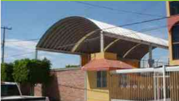
Fig. 42. Imagen Urbana VII. Fotografía de la imagen urbana de la zona del terreno. Fotografía del autor.
