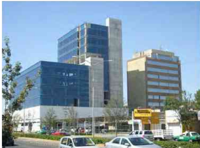
Fig. 12. Hospital Aranda de la Parra. Conjunto médico del Hospital Aranda de la Parra, casi finalizada la nueva torre que se encuentra a la izq. de la imagen. Fotografía SKYSCRAPERCITY.
