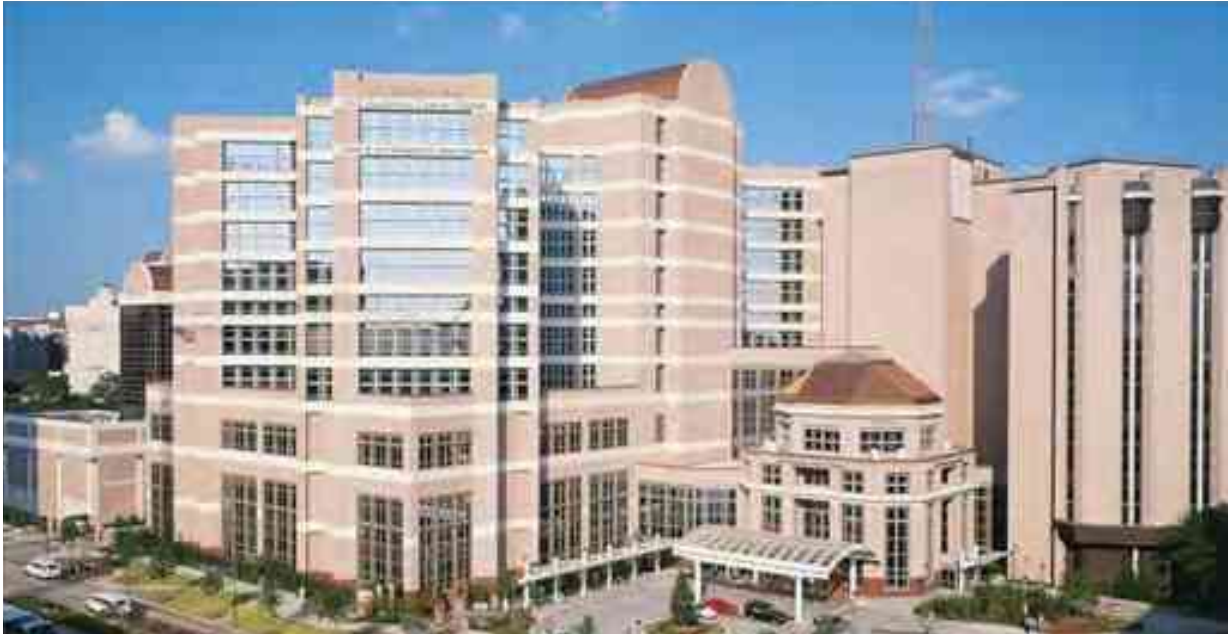
Fig. 09. MD Anderson II. Edificio del MD Anderson Cancer Center en la Universidad de Texas. Fotografía de MD Anderson Cancer Center.
