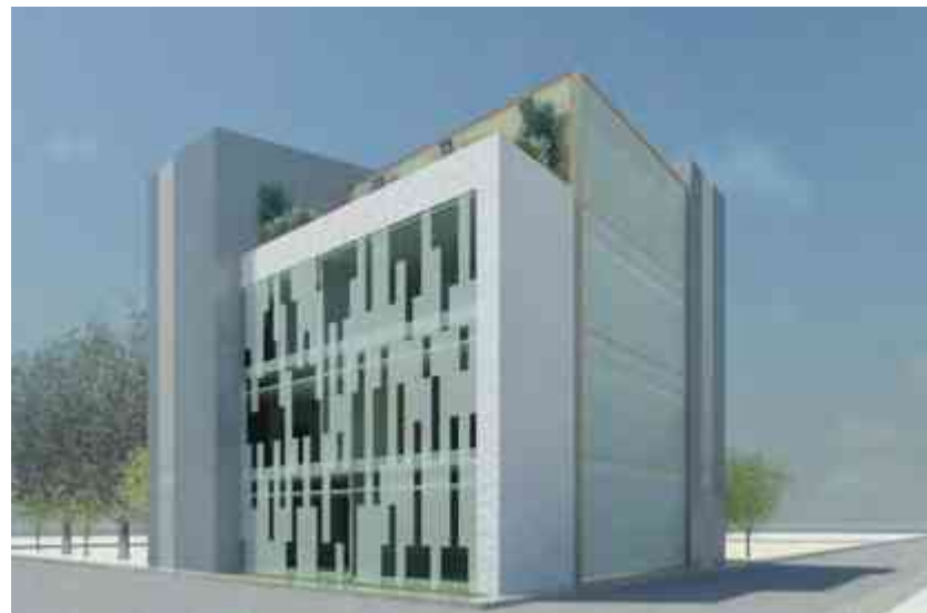
Fig. 70. Pielés y soportes. Perspectiva de la propuesta de la clínica, donde se ve la aplicación de los paneles de aluminio, vidrio y concreto. Imagen del autor.
