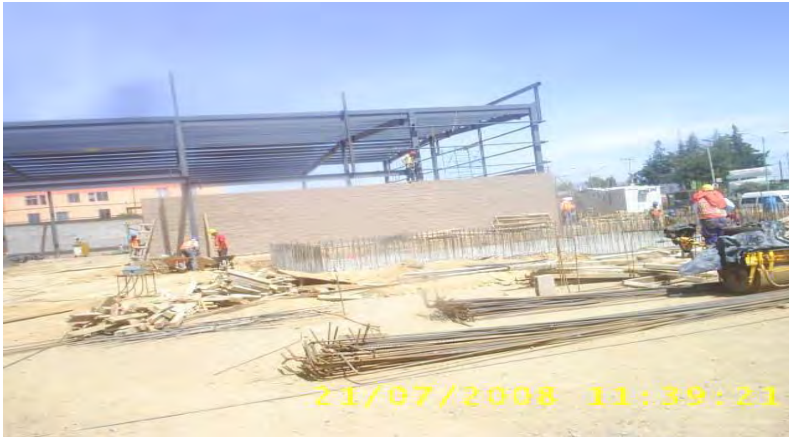
Imagen 43. Emparrillado de monten para recibir la laminación
