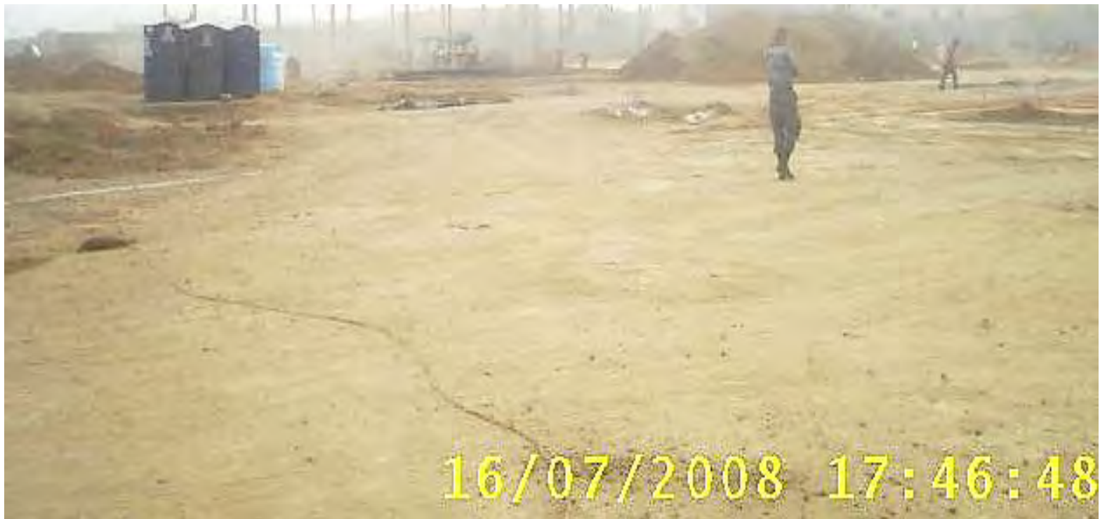
Imagen 36. Terreno elevado por medio de terracería de base y sub base
