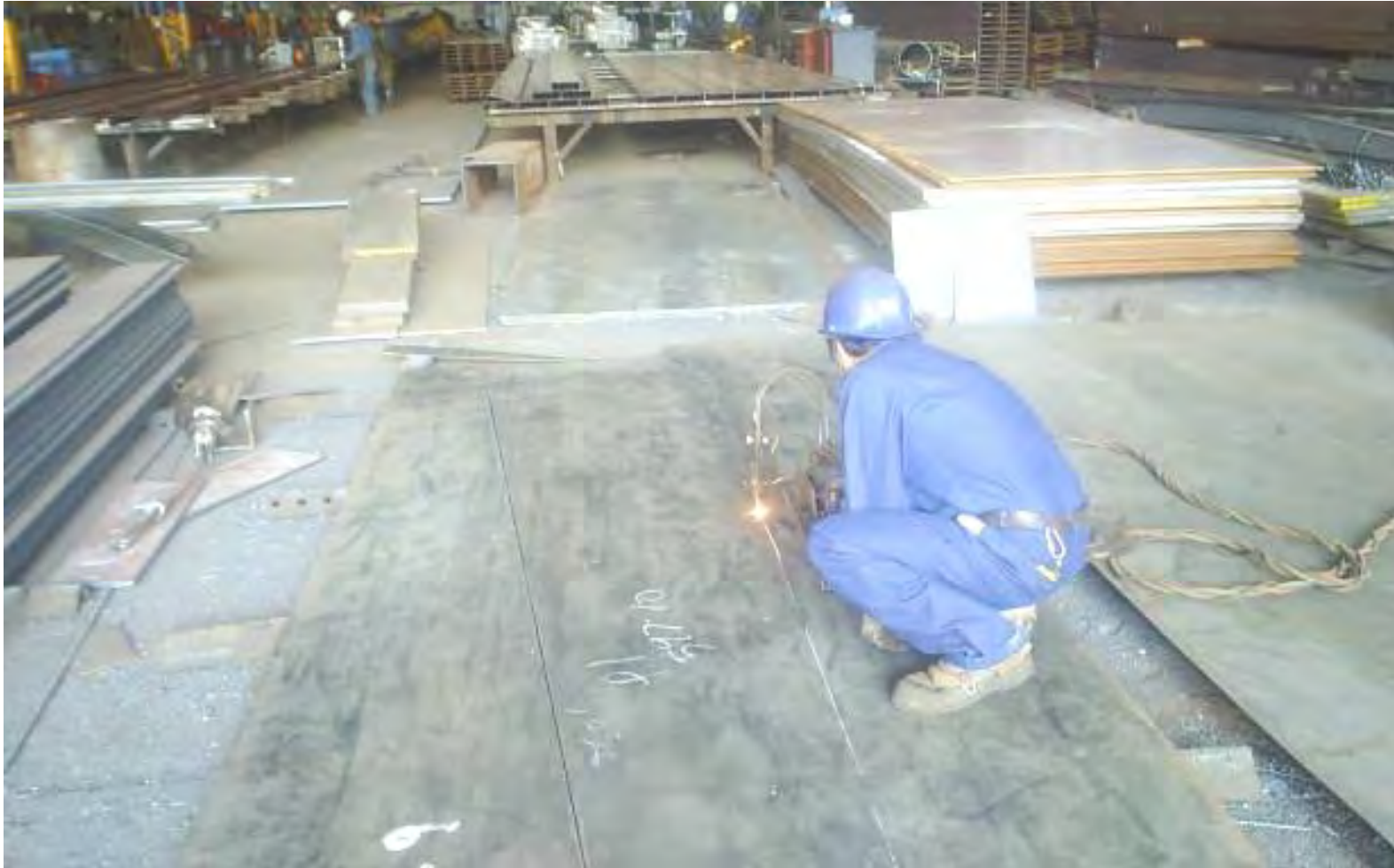
Imagen 40. Habilitado de elementos estructurales
