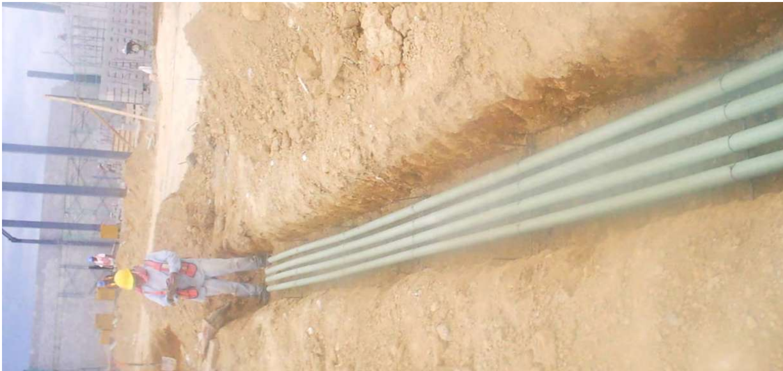
Imagen 39. Ductos eléctricos
