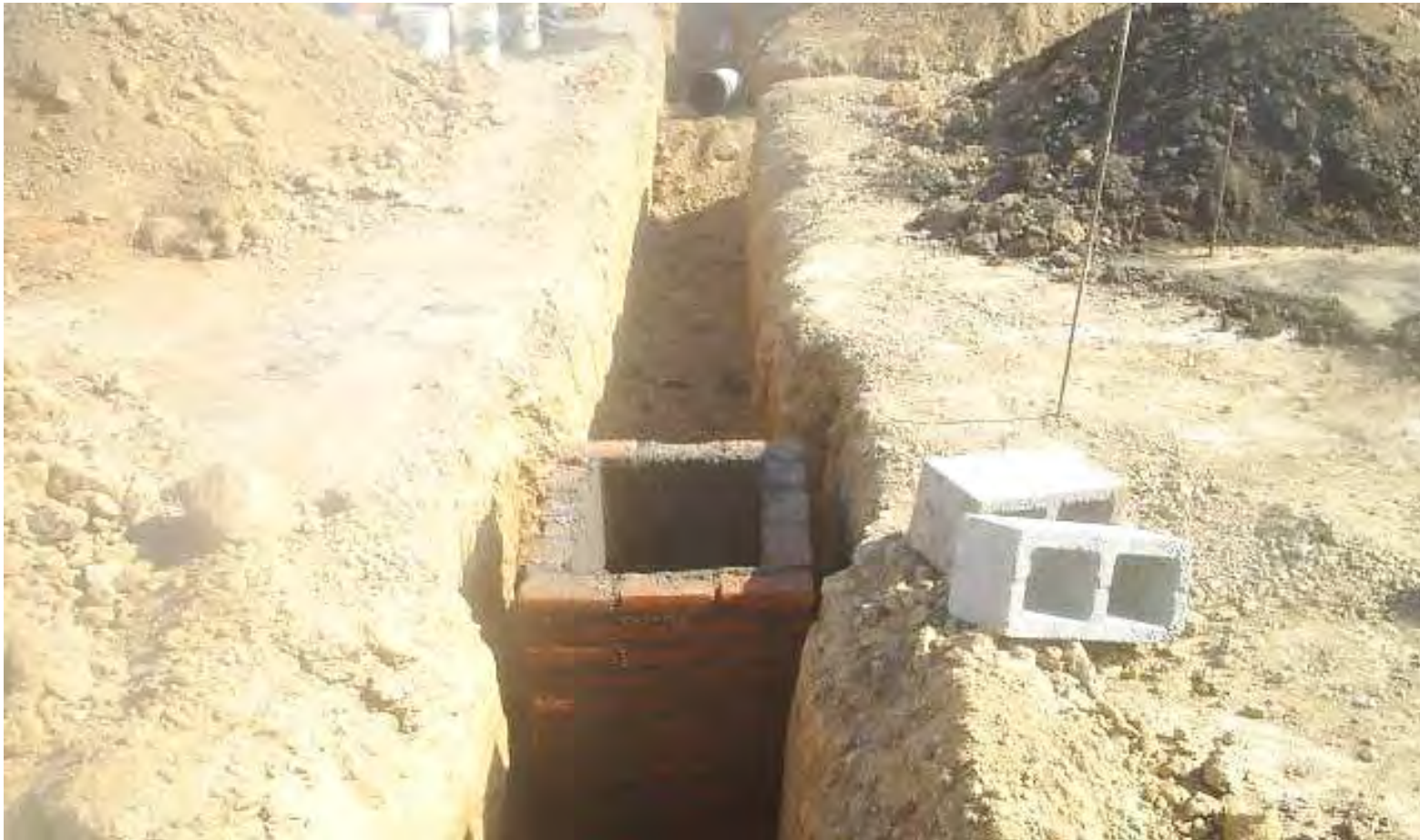
Imagen 38. Excavación y registros pluviales
