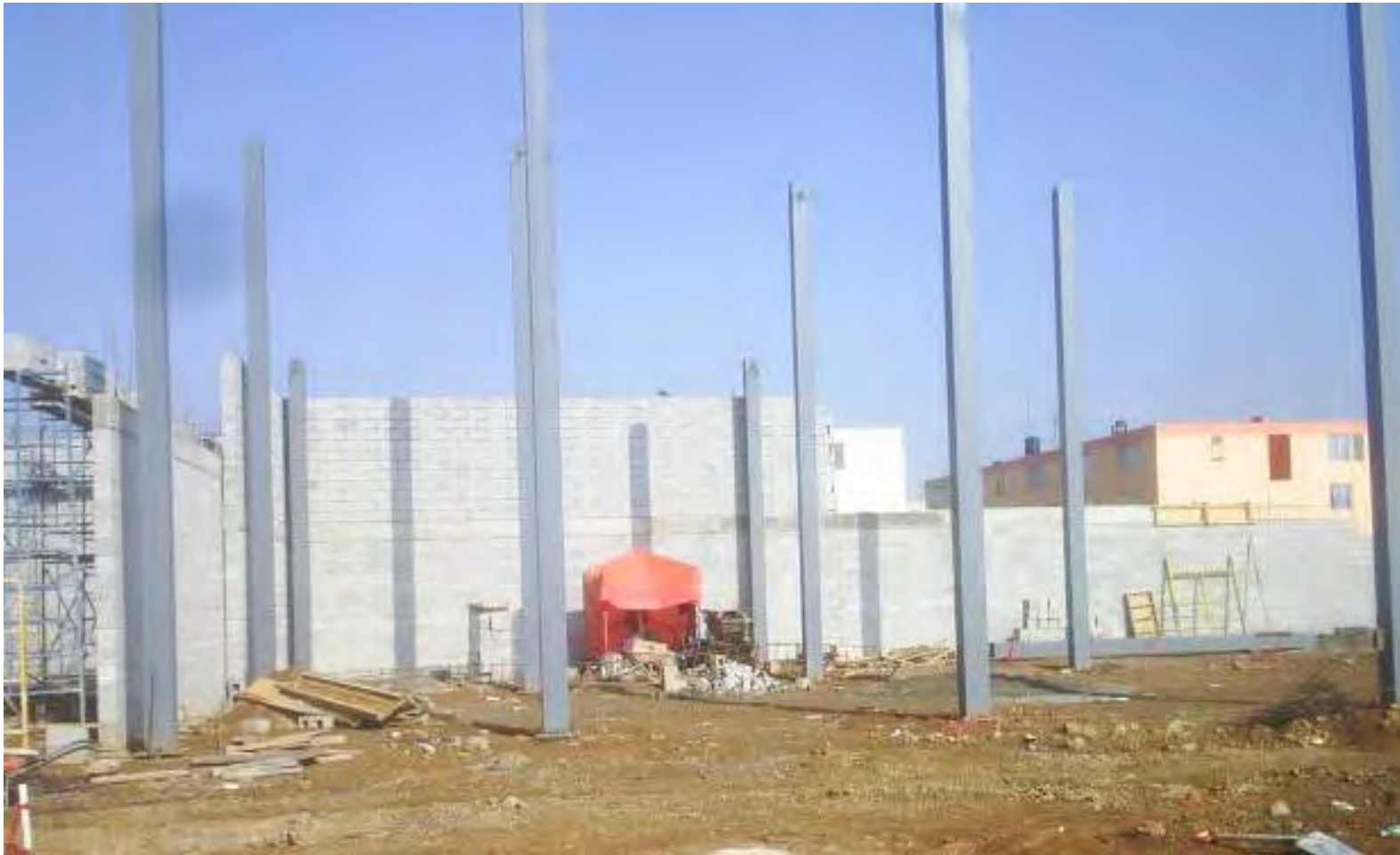
Imagen 41. Colocación de columnas metálicas
