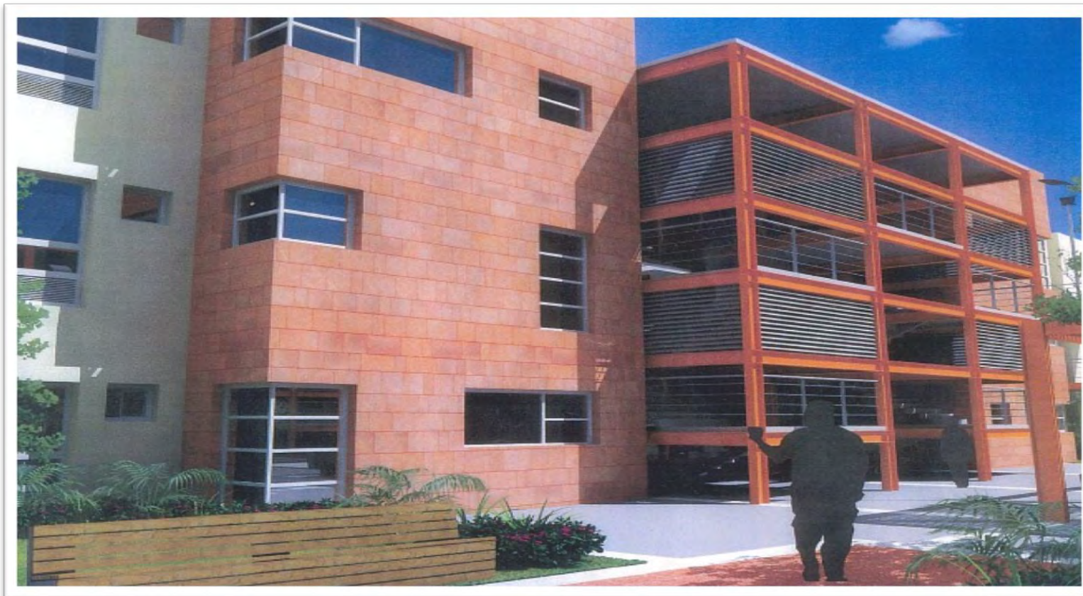
Figura 49. Fachada principal de Residencias Estudiantiles, Ciudad Obregón, Sonora, 2007.
