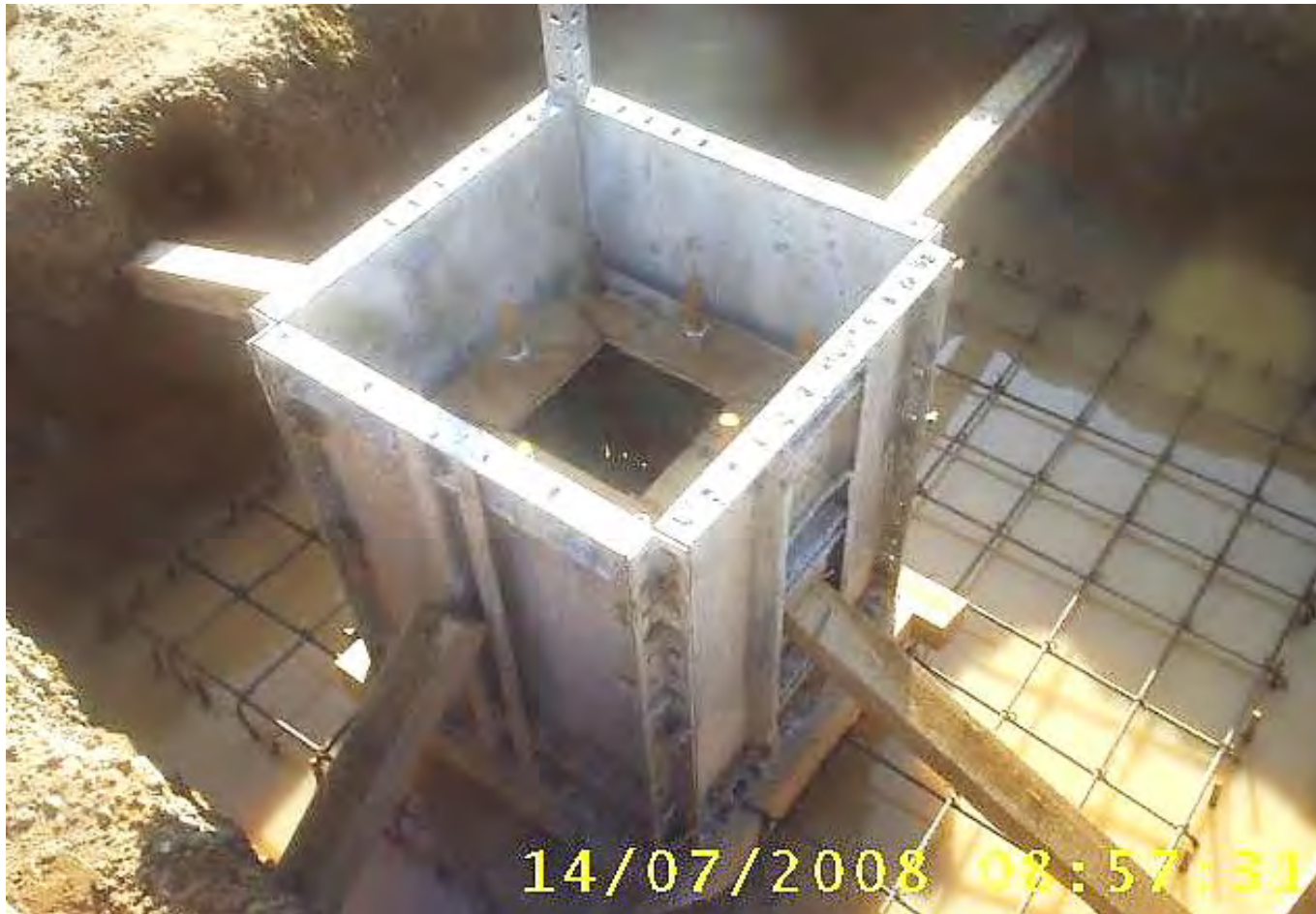
Imagen 37. Excavación, armado y cimbra de zapata aislada
