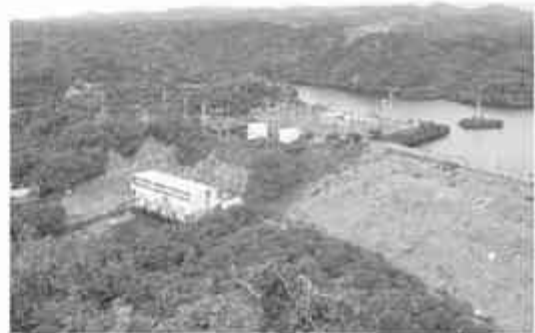
Imagen 38. Vista de la Hidroeléctrica La Villita. 44
