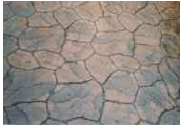
ACABADO EN PIEDRA LAJA PARA PATIO CENTRAL, COLORES VARIOS MATERIAL DE LA REGIÓN.
