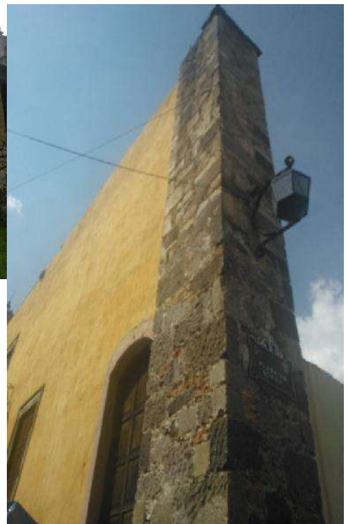
Muro de Contención Inmueble
