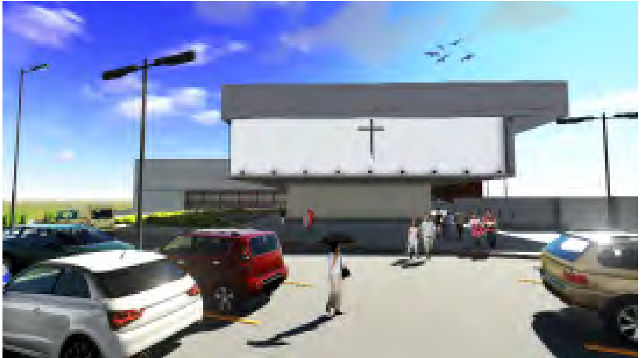
1. Fachada Poniente del Edificio vista desde el estacionamiento.
