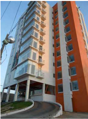
Fig. 4 Fachada principal de Torres Alpha
