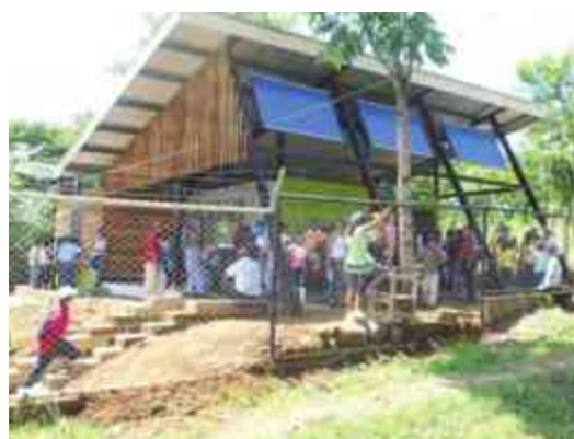
Ilustración 6: Aula multiusos y Centro comunitario, Siuna, Region Autonoma del Atlantico Norte, Nicaragua. Recuperada en http://openarchitecturenetwork.org/projects/multiuse_classroom_nic el 13 de enero del 2013.
