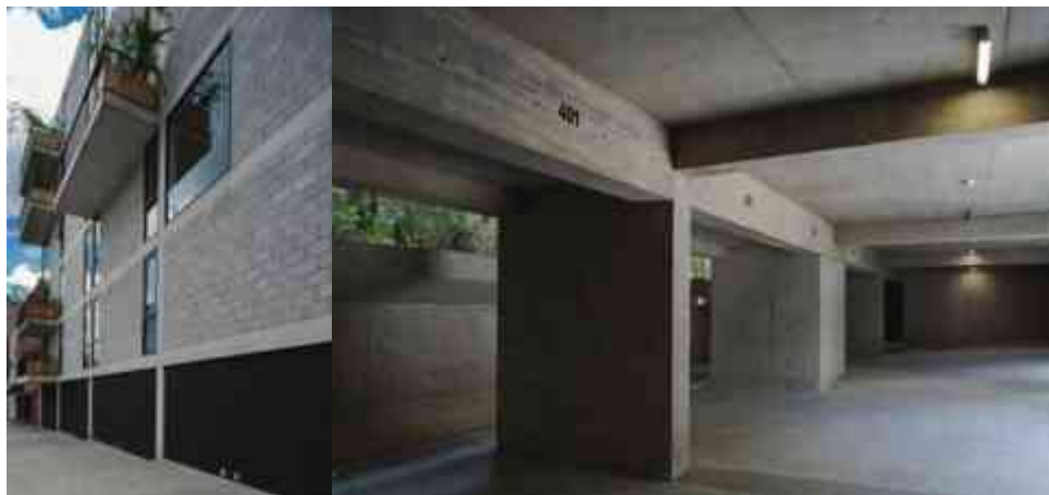
Ilustración 8: Imagen del conjunto departamental por los arquitectos Ambrosi / Etchegaray . Recuperada en http://www.archdaily.mx/187538/alfonso-reyes-200-ambrosi-i-etchegaray/ , el 12 de noviembre del 2012.
