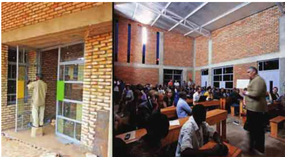
Ilustración 35: Apreciación del acabado exterior e interior del Centro Kimisagara Fútbol por la Esperanza. Recuperada en http://openarchitecturenetwork.org/projects/esperance el 12 de octubre del 2012.
