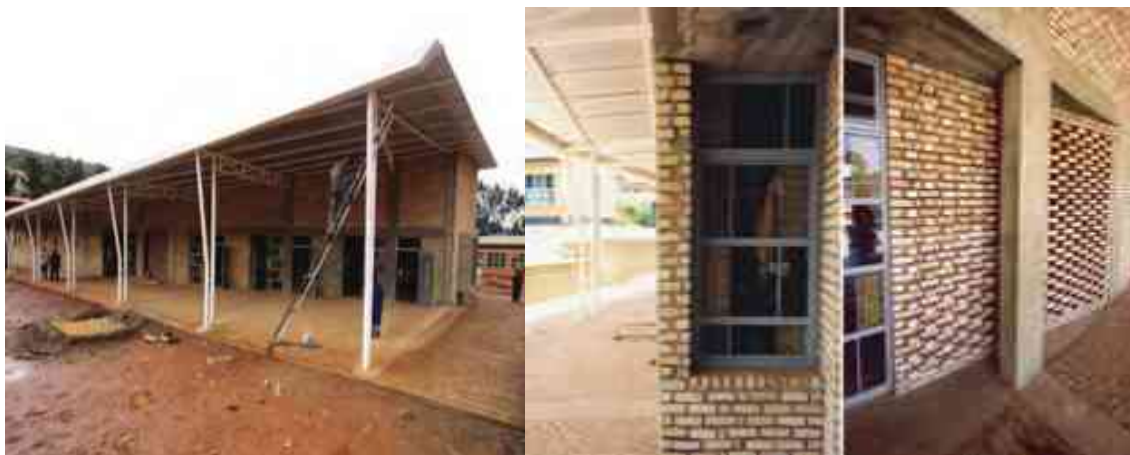
Ilustración 33: Apreciación de la estructura y aberturas para ventilación natural Centro Kimisagara Fútbol por la Esperanza. Recuperada en http://openarchitecturenetwork.org/projects/esperance el 12 de octubre del 2012.
