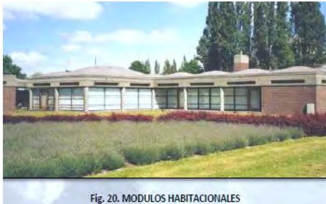
Imagen 14-15 Forma espacios a través de muros rectos de tabique al descubierto columnas circulares de acero techos en forma de bóvedas, en las zonas exteriores utiliza plantas para la decoración de la edificación,. Una cualidad espacial del proyecto es la articulación del conjunto.
