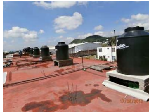
Fotografía 9.- vista desde azotea.
