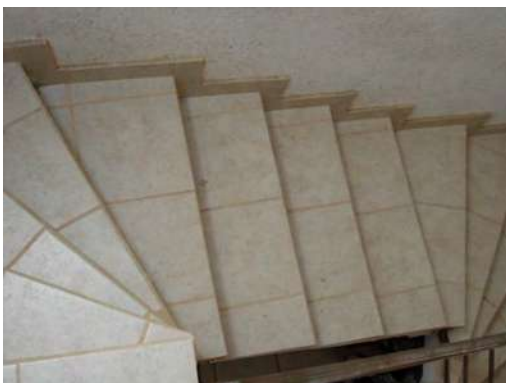
Fotografía 7.- acabado en escalera.
