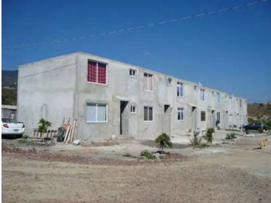
Fotografía 1.- vista exterior del conjunto.
