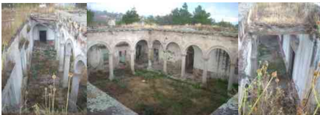
Foto 30. Vista desde la azotea. MCHB.06/01/13.
